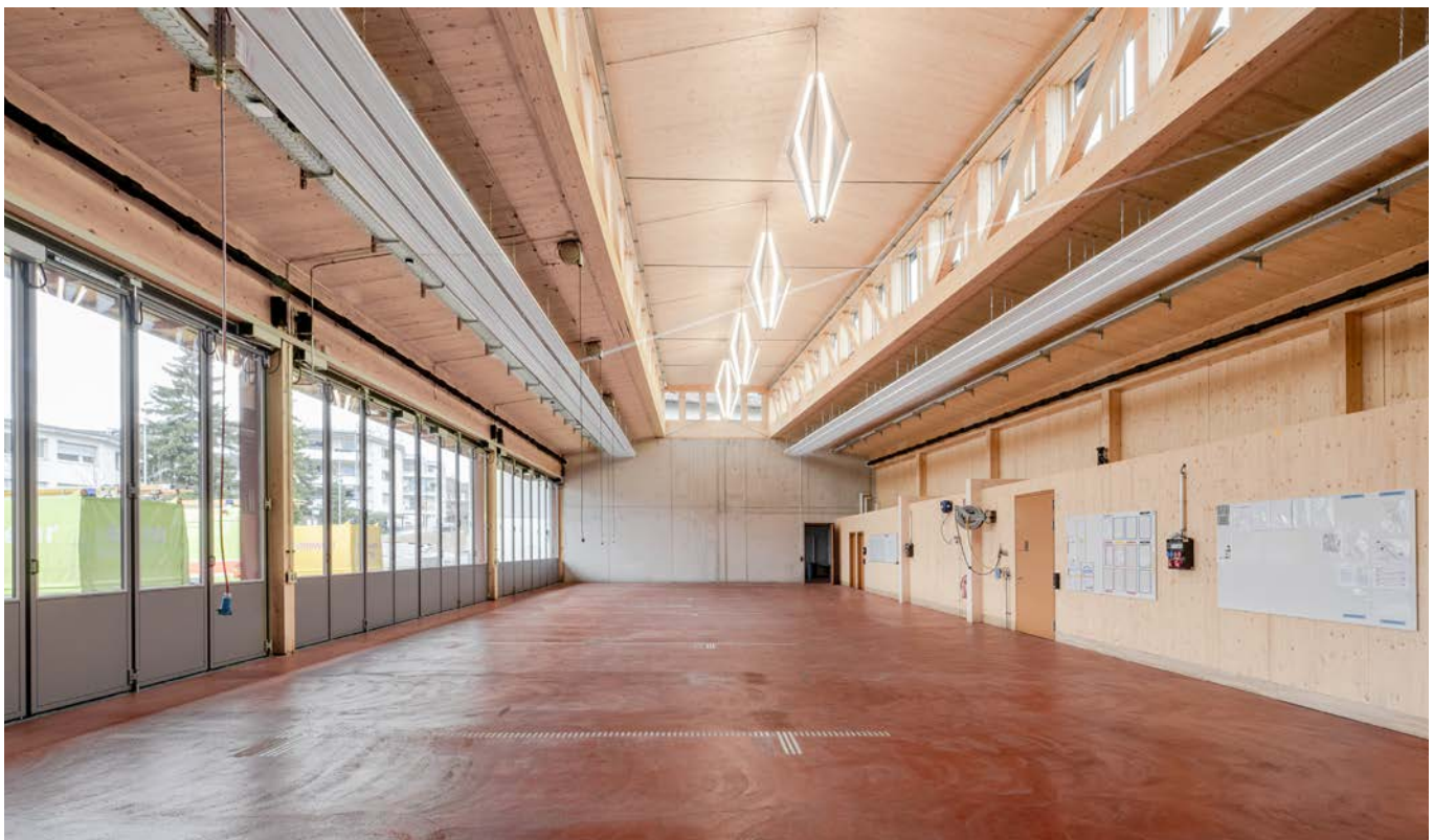
Für die erstausrückenden Fahrzeuge die Halle mit dem Oblicht: Die Lasten zwischen den Betonscheiben werden von den Fachwerken getragen.
