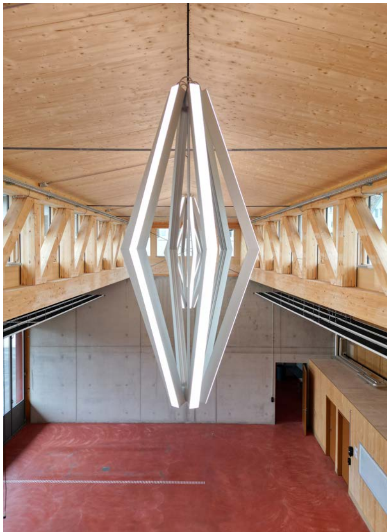
Zwei markante Fachwerke tragen das Dach. Auch das künstliche Licht ist praktisch und ästhetisch.
