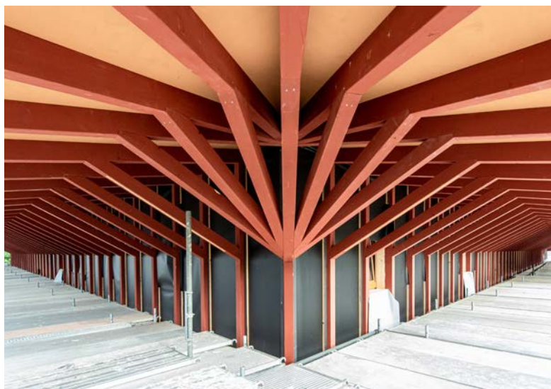
Die roten Sparren des drei Meter auskragenden Vordachs markieren eindeutig: Wir sind ein Holzbau.
