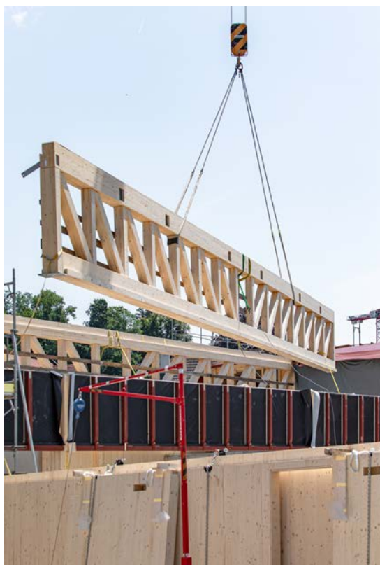
Die beiden rund 27 Meter langen Fachwerke wurden in der Egli Zimmerei abgebunden und fertig angeliefert.
