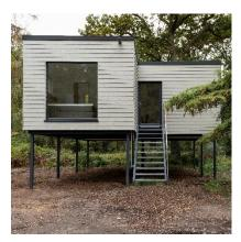
Die Häuser werden auf einem Stahlgrundgerüst mit oberseitigem Holzrahmen gebaut, das mit Punktfundamenten im Boden verankert ist.
