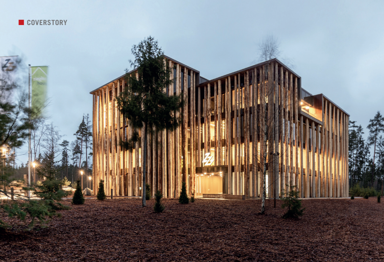
Hohes Holz: Rund 200 bis zu 19 m hohe Baumstämme bilden die namensgebende Außenhülle.
