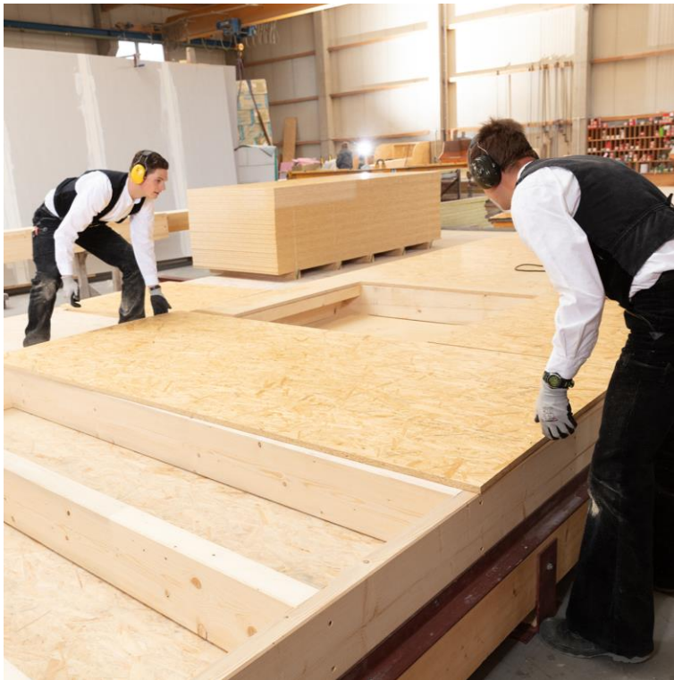
Vorfertigung von Wandelementen im Werk
