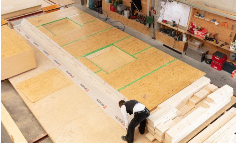
Vorfertigung großformatiger Wandelemente
