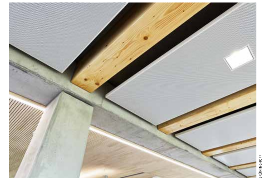
▶ Das Tragwerk des Sechsgeschossers besteht neben Stahlbeton zu einem Großteil aus Holz
