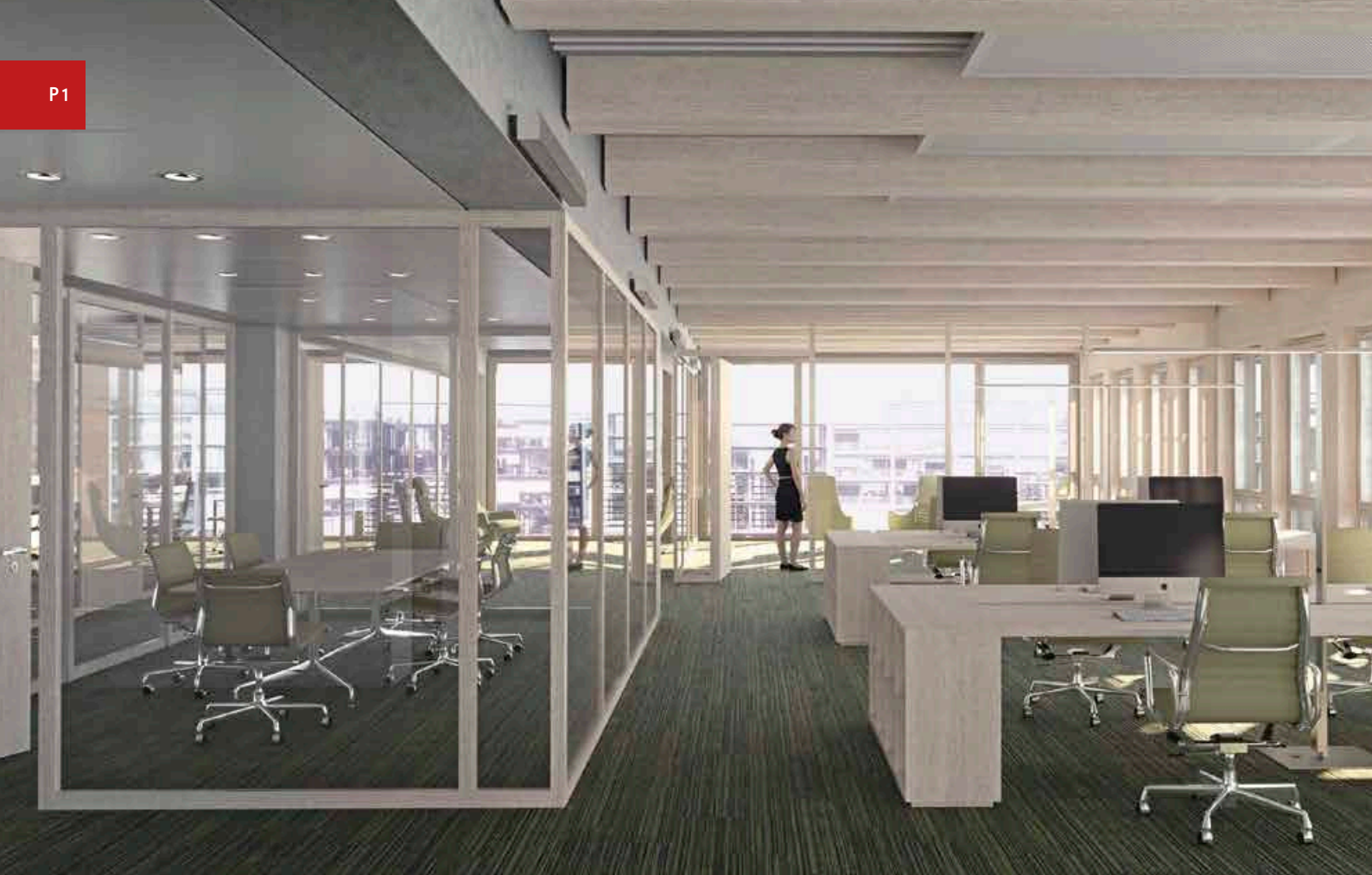
▲ Die Holz-Außenwände und die Holzbalken der Hybriddecken sind sichtbar geblieben
