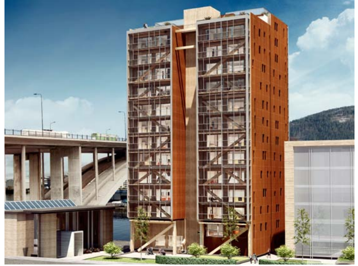
Der gerade fertig gestellte 14-Geschosser in Bergen zeigt, dass die Grenze des Machbaren im Holzbau ausgelotet wird
