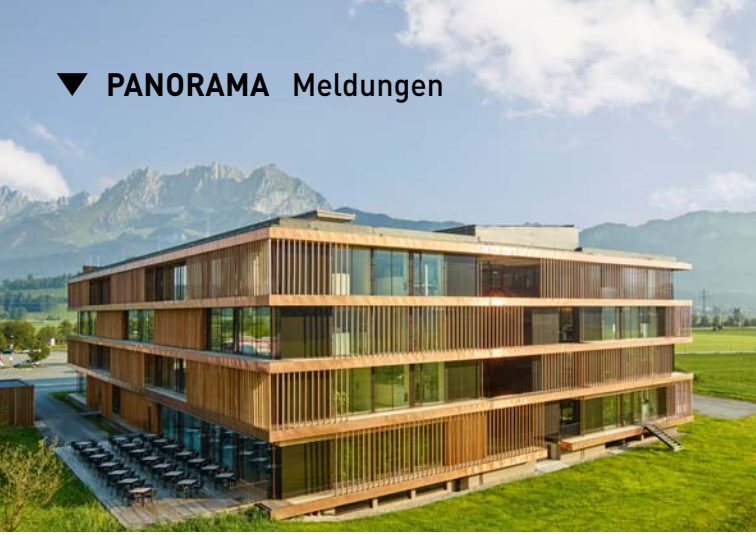
Im Themenblock „Modulbauweise“ wurde das Stammhaus von Egger in St. Johann in Tirol vorgestellt
