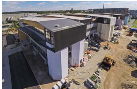
Projekt TM 50: Der ehemalige Foto-Quelle-Bau in Nürnberg wurde umgestaltet und aufgestockt
