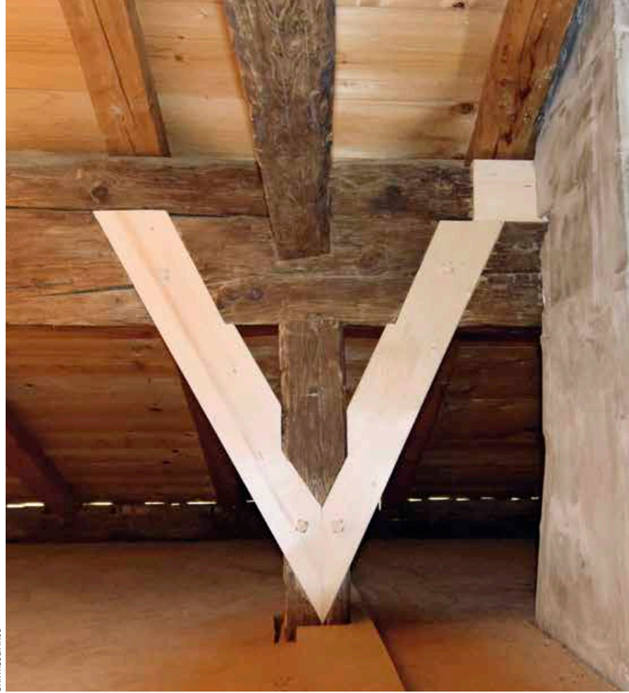
▲ Im Dachstuhl wurden fehlende Bauteile querschnittsgleich ergänzt
