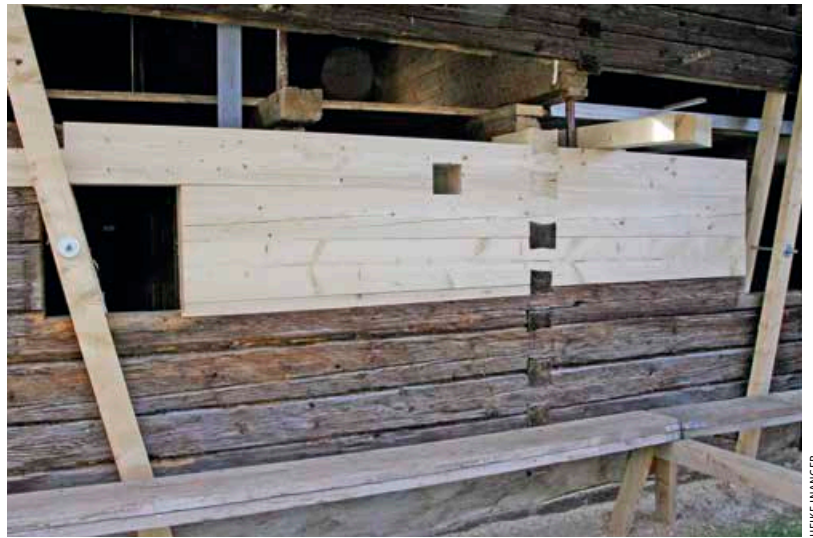
► Blockwand während der Sanierung
