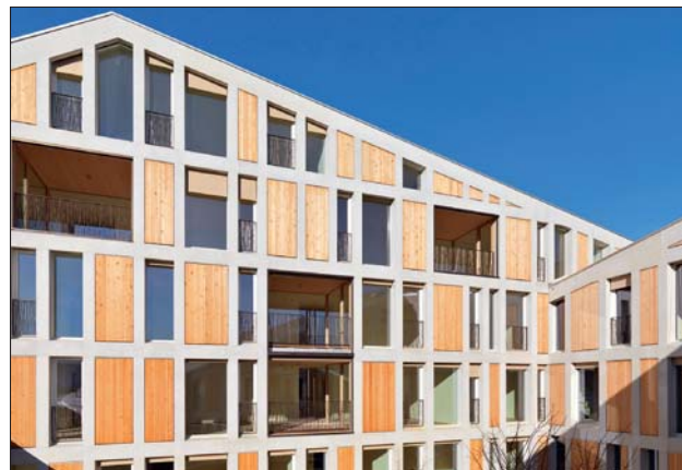
Senioren-Wohnhaus in Teufen: Im geschützten Innenhof wird das Betonfassadenraster mit den gefüllten Gefachen aus Holzelementen (Täfer) oder Glas direkt erlebbar. Foto: Ulrike Hörler-Körner
