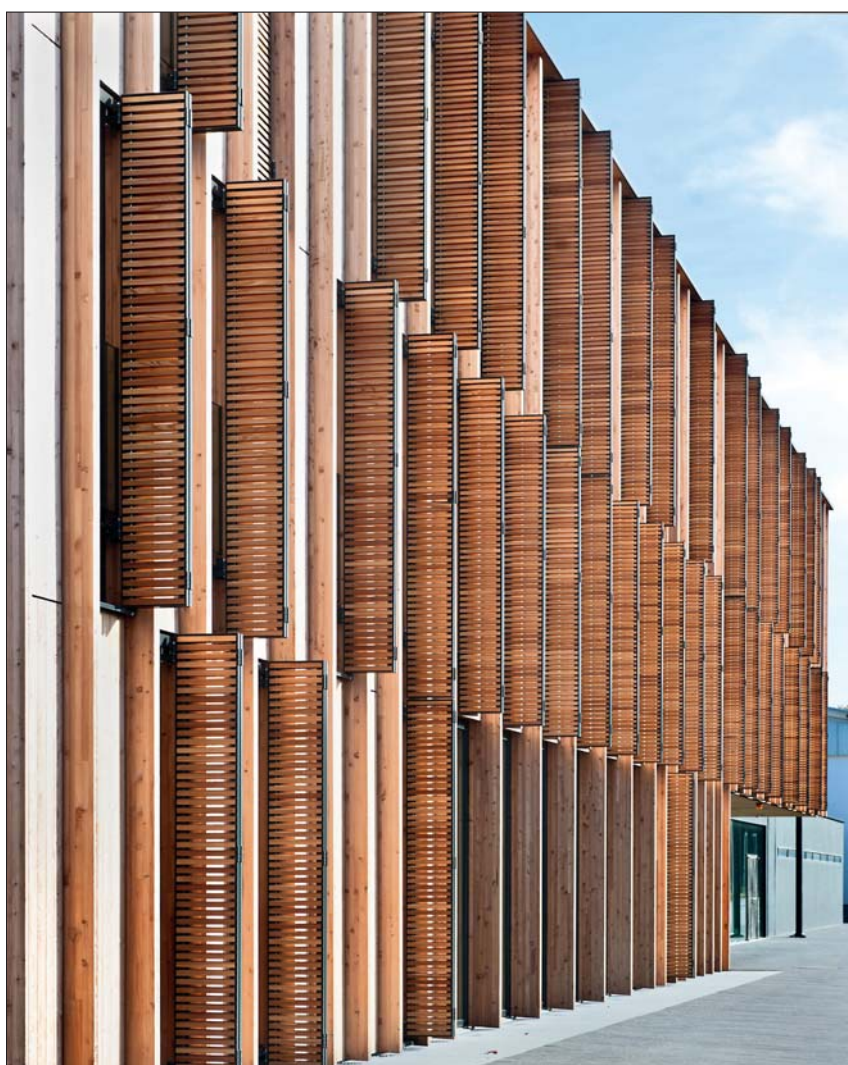
Don Bosco: In der Schrägsicht verdecken die hervorstehenden Lisenen die Fenster. So entsteht beim Betrachter je nach Blickwinkel die Illusion einer reinen Holzfassade. Foto: Leistner/Fritsch Architekten
