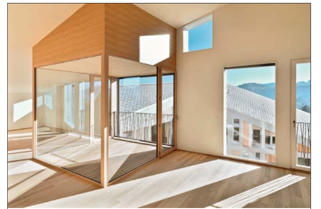
Für die innere Tragstruktur nutzten die Architekten Brettspertholz (für die Wände) und Lignatur-Hohlkasten-Elemente (für die Decken). Nach Fertigstellung bleibt das Holz aber nicht überall sichtbar. Foto: Kathrin Schulthess
