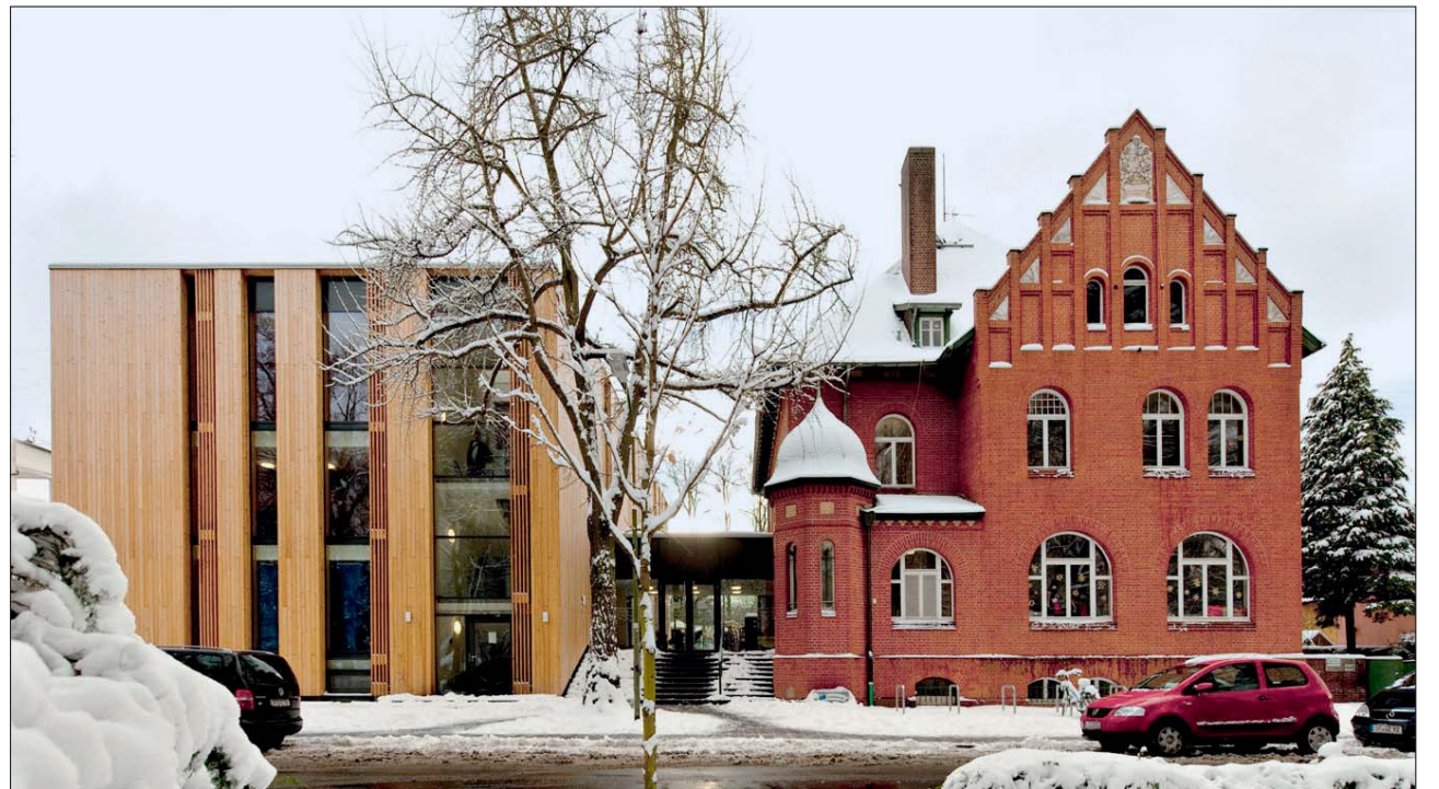
Erasmus-Schule: Der moderne kubische Erweiterungsbau der Schule wurde mit Lärche verschalt und ergänzt die bestehende Villa aus rotem Backstein kontrastreich. Foto: Leistner/Fritsch Architekten
