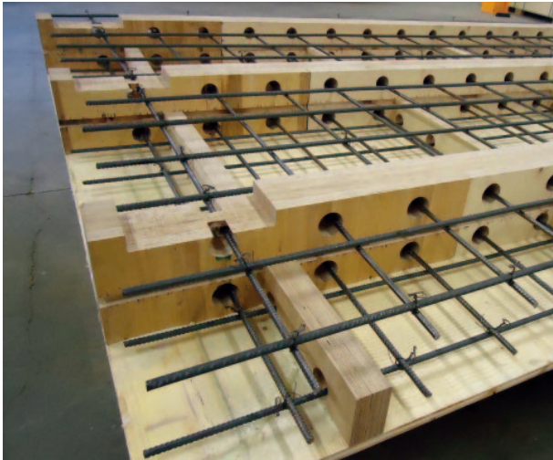
Neuentwickelte Holz-/Betonverbunddecke X-Floor: Diese mit eingelegter Armierung vorgefertigte Kreuzrippendecke wirkt in zwei Tragrichtungen.
