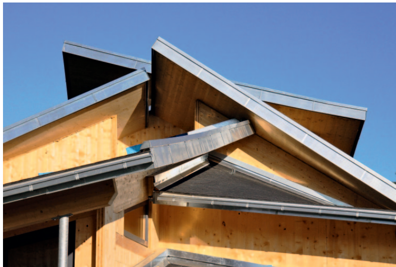
Green building: Dreigeschossiges Ökohaus mit 300 mm dicken, massiven Holzwänden und einer modernisierten Form des «winschen Scheunendaches.» Foto: arch-atelier frey
