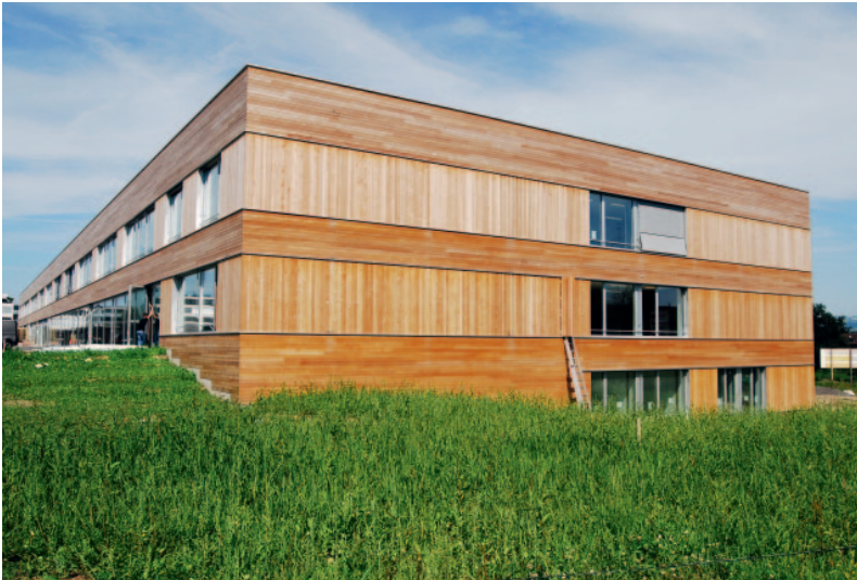
Hat die Zielwerte des SIA-Effizienzpfades Energie erfüllt: Schulhaus «Eichmatt» der beiden Einwohnergemeinden Hünenberg und Cham. Der Input an nicht erneuerbarer Primärenergie liegt bei 350 MJ/m 2 a. Foto: W. Bogusch
