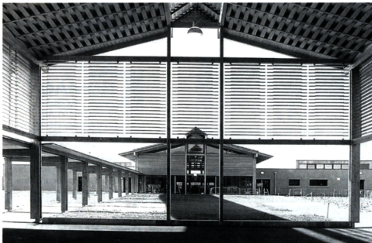
Französischer Ingenieurholzbau in einer Schule in Chatte, Region Rhône-Alpes (F). Baujahr 2006. Bild: Véronique Klimine, Grenoble (F)
