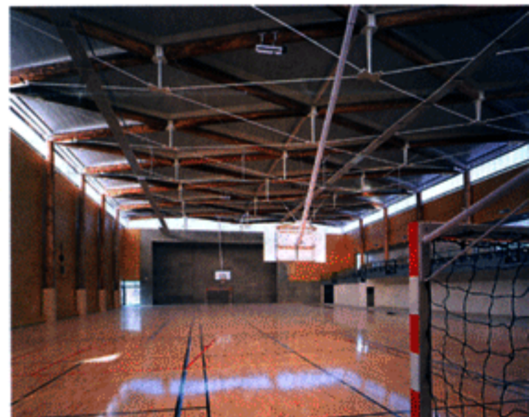
Tragwerk aus Rundholz und Stahl für die Turnhalle des Gymnasiums in Meylan, Region Rhône-Alpes (F). Baujahr 2002.
