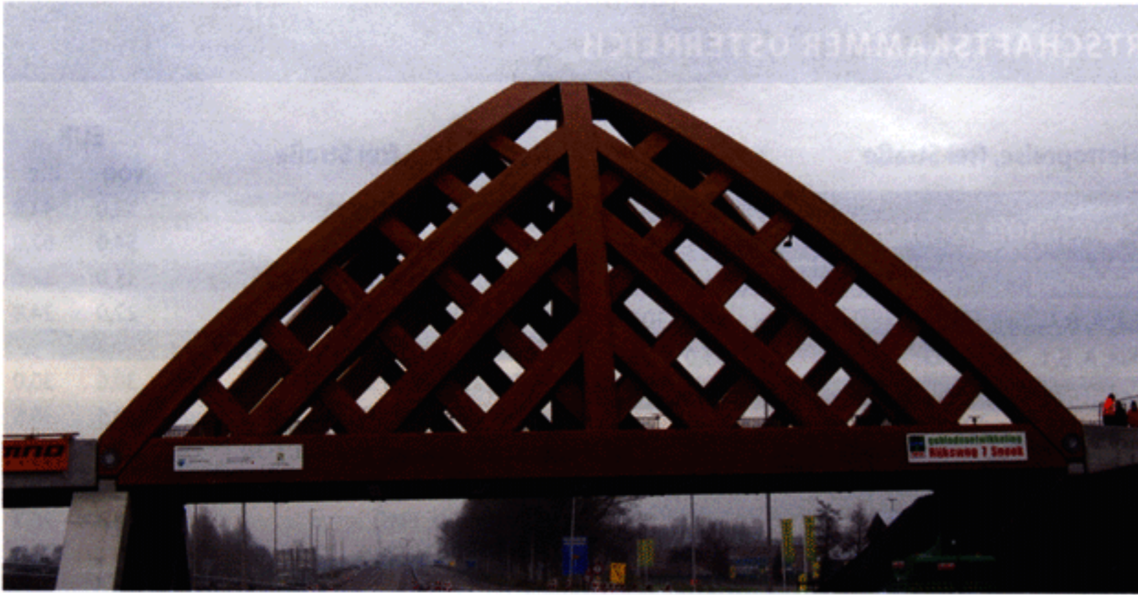
Schwerlastbrücke aus acetyliertem Holz für 60 t Belastung zugelassen
