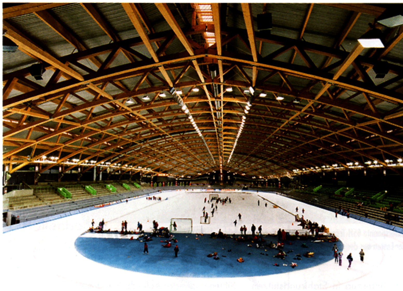
Für weitgespannte Holz-Tragwerke (im Bild: die imposante Viking-Halle in Hamar N) vertrauensfördernd sind die auf die Lastfälle abgestimmten, normgerechten Bemessungen. Foto: W. Bogusch
