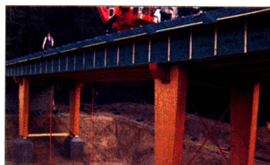
Straßenbrücke Neukirchen während der Montage. Senkrechte Stützen tragen das Brückenbauwerk. Längsträger und Stützen werden mittels hinterlüfteten Dreischichtplatten bekleidet.
