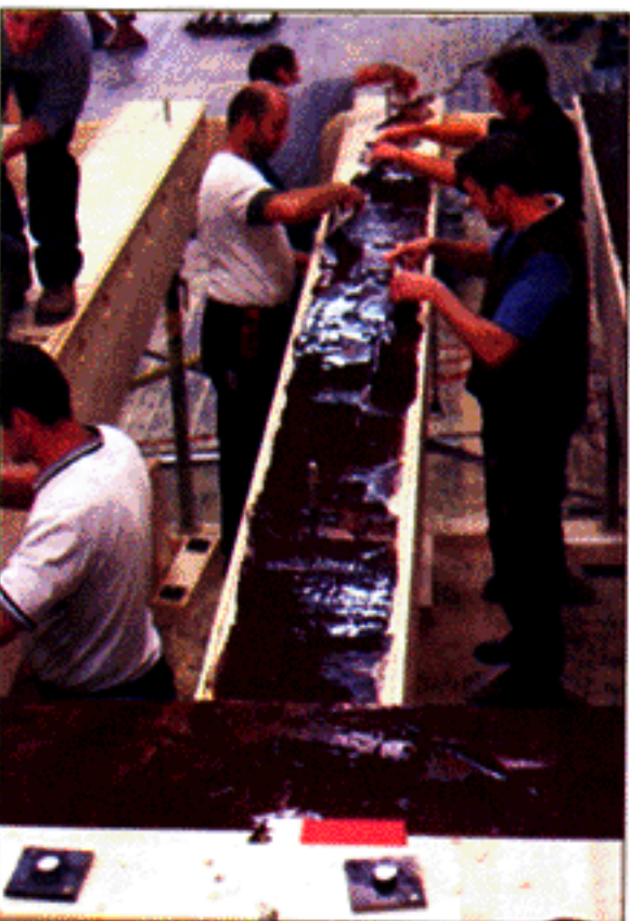
Auftrag von Resorcinharzleim auf die Oberseite der BSH-Längsträger; anschließend wird die Holzplatte aufgelegt und der Pressdruck aufgebracht.
