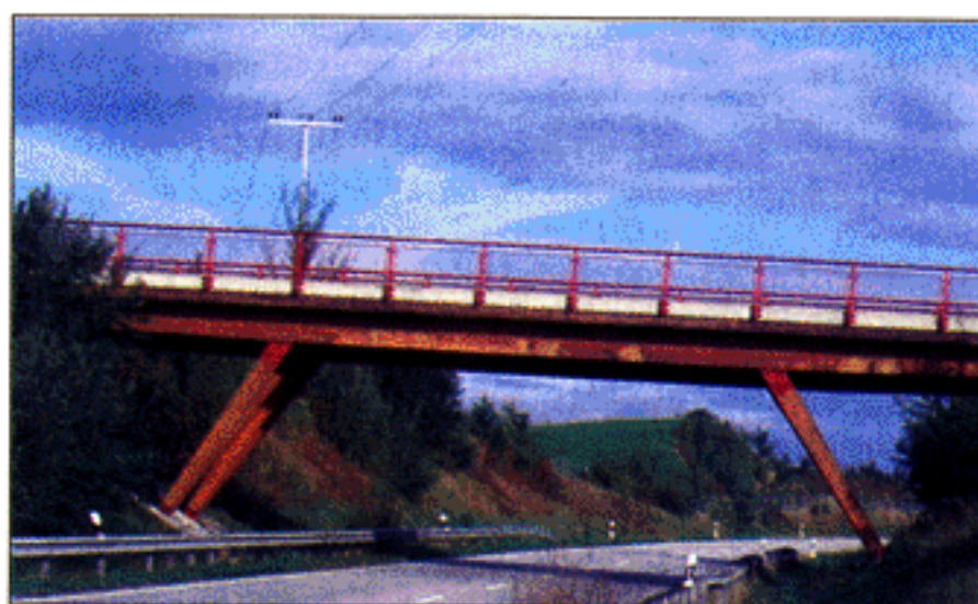
Brückenprojekt in Ruderting nördlich von Passau: Das Tragwerk der 30-t-Brücke besteht aus einem Sprengwerk aus BSH-Stützen, die hier BSH-Balken tragen.
