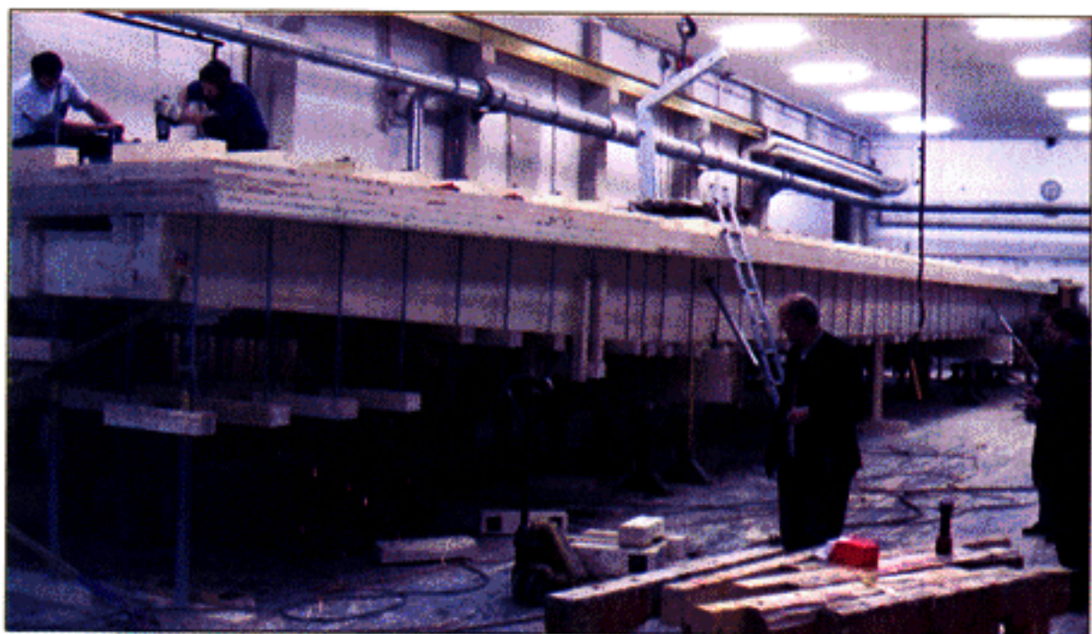
Verleimen und Verpressen der vielschichtigen Holzplatte im Werk Grossman
