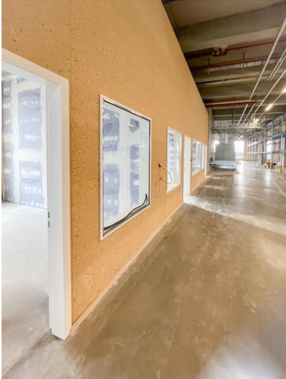
In allen drei Geschossen des Funktionsgebäudes wurden Büroboxen mit elka esb-Platten ausgeführt. Auf Grund der hohen Oberflächenqualität, konnte die Platte sich prima als Sichtoberfläche im Industriebau einfügen. (Foto: Holzbau Amann)
