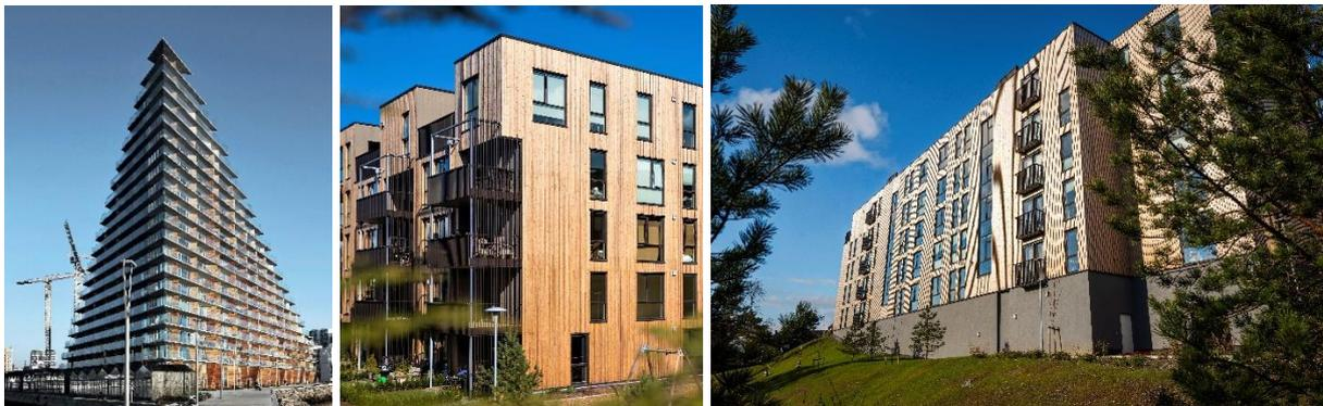
**Brandschutz und Design vereint:** Beplankungen von THERMORY für Gebäudeaußenwände und Terrassen bestehen aus thermisch veredeltem Nadel- oder Laubholz, das sich mittels Woodsafe-Verfahren brandschutztechnisch optimieren lässt. Die natürliche Schönheit des Holzes bleibt dabei erhalten. (Fotos: Kåre Viemose (links) sowie Veronika Stuksrud (Mitte + rechts) für THERMORY AS, Tallinn, Estland)
