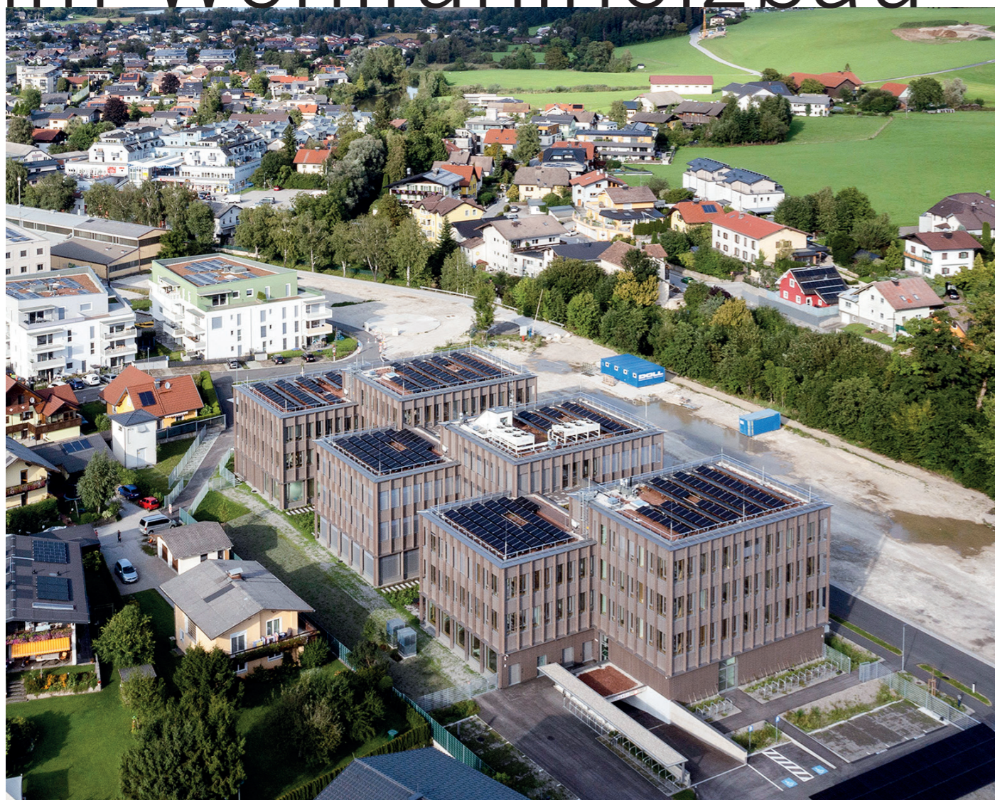
Die sechs auf einem Sockel liegenden Kuben wurden mit dem zentralen Baustoff Holz errichtet.
