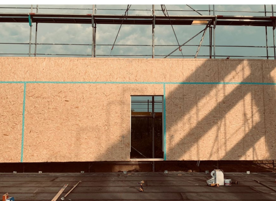
Die Bauteile sind bereits bei Anlieferung luftdicht verklebt
