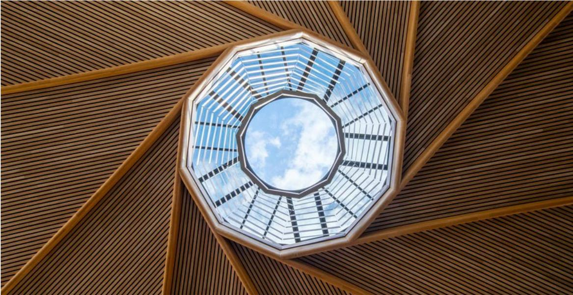
Im Inneren der Weinkellerei verleiht der Dachstuhl dem Raum sublimen Eleganz. Das Zentrum der Konstruktion krönt ein herrlicher, aus **Brettschichtholz aus Eiche** zusammengefügter Stern. Er ist eines der zahlreichen Details, die in dieser von keinerlei Säulen oder Trägerelementen unterbrochenen Halle für Ambiente und Leichtigkeit sorgen. Die damit verbundenen bautechnische Herausforderung ließ sich dank der **Vorteile von VICAM als Baustoff für tragende Zwecke** natürlich lösen.
