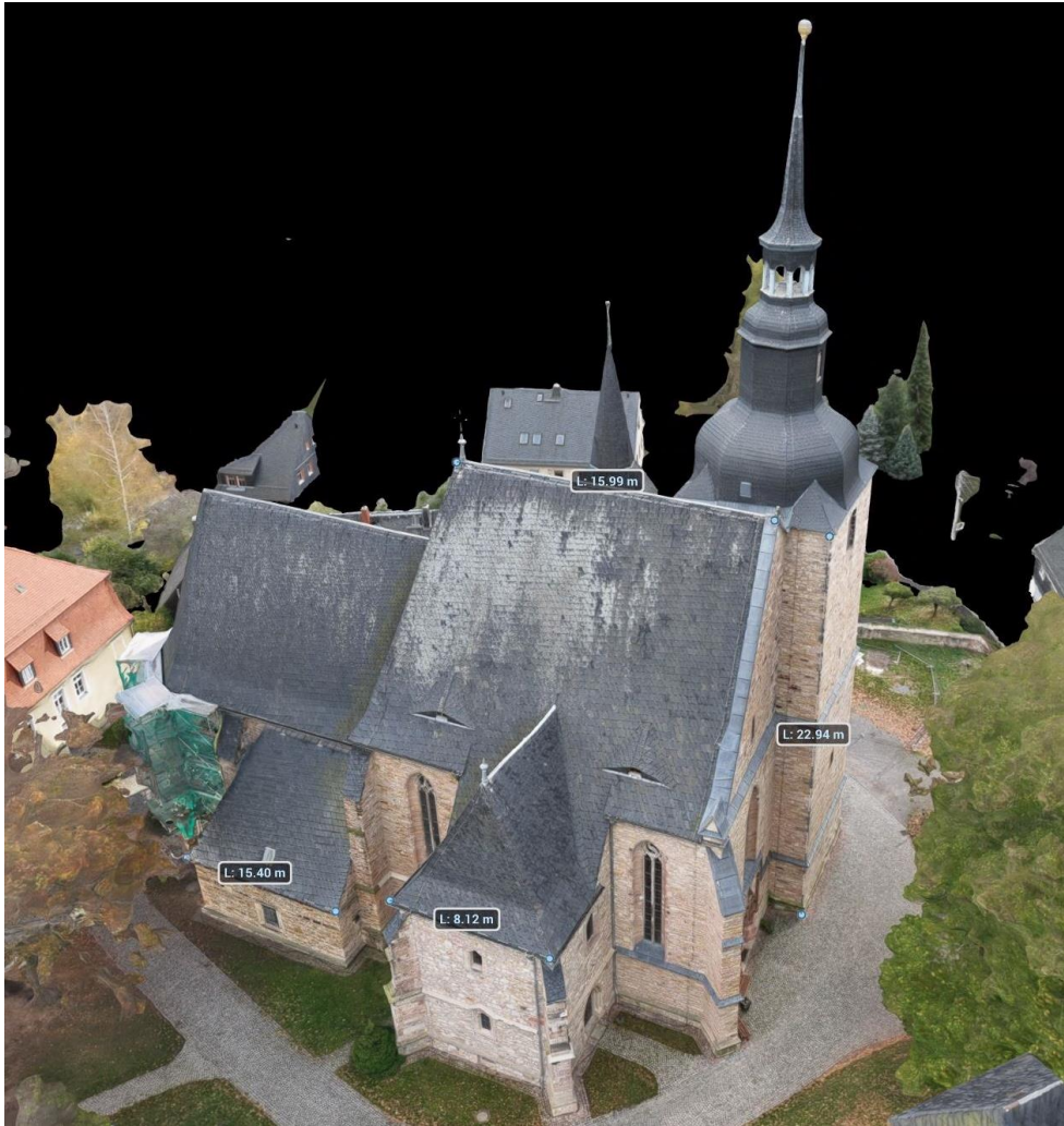
Abbildung 2 - Vermessung der Flächen am digitalen Zwilling, welcher durch die Drohnenvermessung erzeugt wurde
