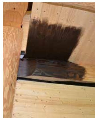
▲ Die hölzernen Innenbauteile des Restaurants und der Motels wurden mit einer Lasur beschichtet
