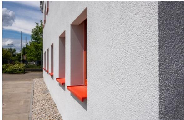
*Zusammen mit der Holzfaserdämmplatte aus Schwarzwaldholz und den verschiedenen Putzkomponenten erfüllt das Wärmedämmverbundsystem von GUTEX höchste baubiologische Ansprüche.*
