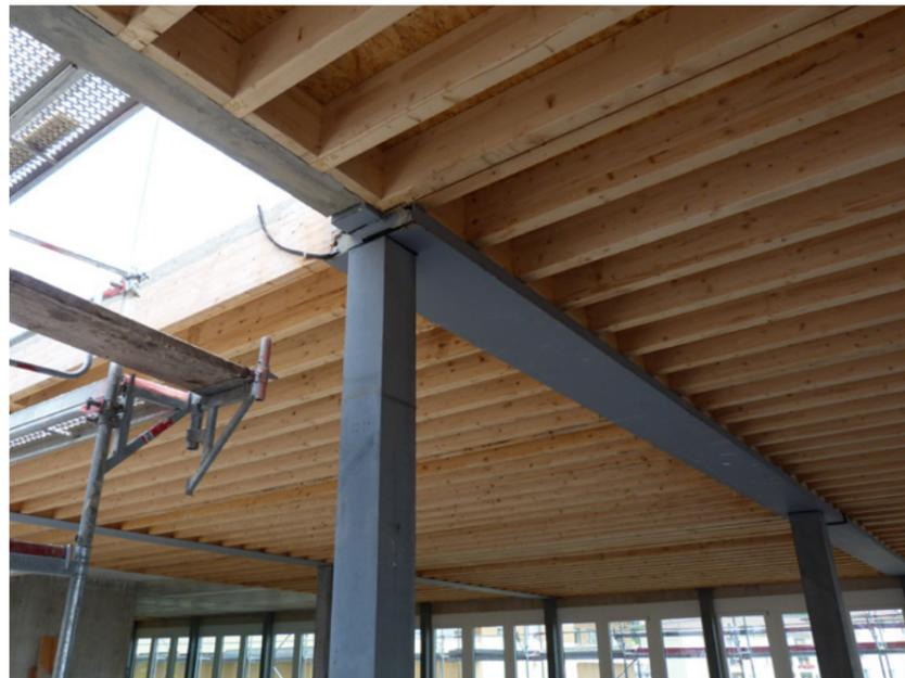
So lassen sich in der Regel zwischen 10 und 30 % der Deckenstärke – und Gebäudehöhe – einsparen und die Deckenunterseite ist praktisch eben. Beim MicroCity-Gebäude leiten die meisten DELTA BEAM® Verbundträger die anfallenden Lasten über Fertigteilstützen ab. Und auch hier machen Peikko-Produkte den Gebäudebau wesentlich effizienter. In diesem Fall erleichtern sie die Schalungsarbeit im Betonfertigteilterwerk.
