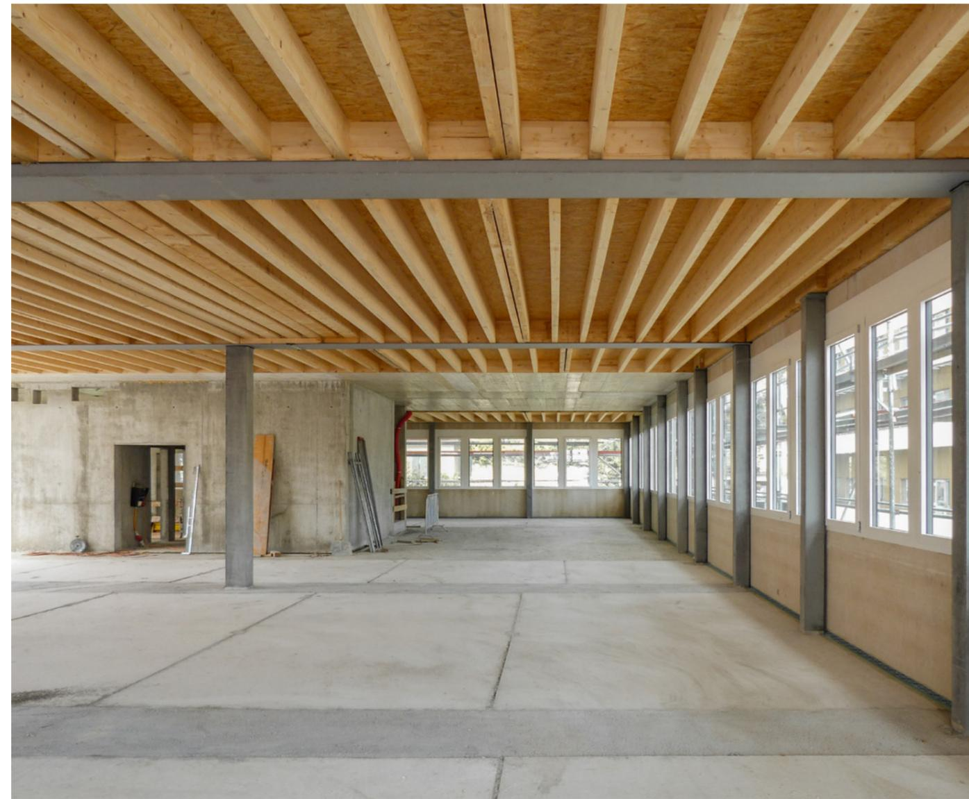
▲ Die unterzugslose Deckenunterseite ist der große Vorteil der DELTA BEAM® Verbundträger.
