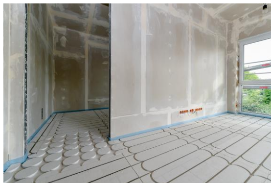
Mit dem Einbau von fermacell® Therm25 Fußbodenheizelementen von James Hardie konnte eine schlanke Aufbauhöhe von 35 cm realisiert werden. Bildnachweis: James Hardie Europe GmbH
