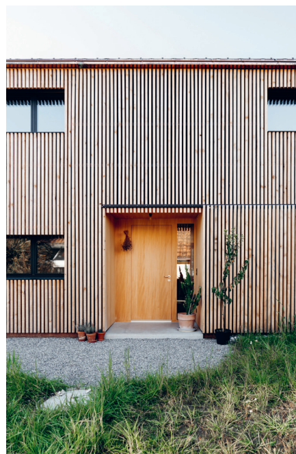
Die Türnische kann mit einem Schiebeladen aus den Fassadenlatten zugezogen werden.
