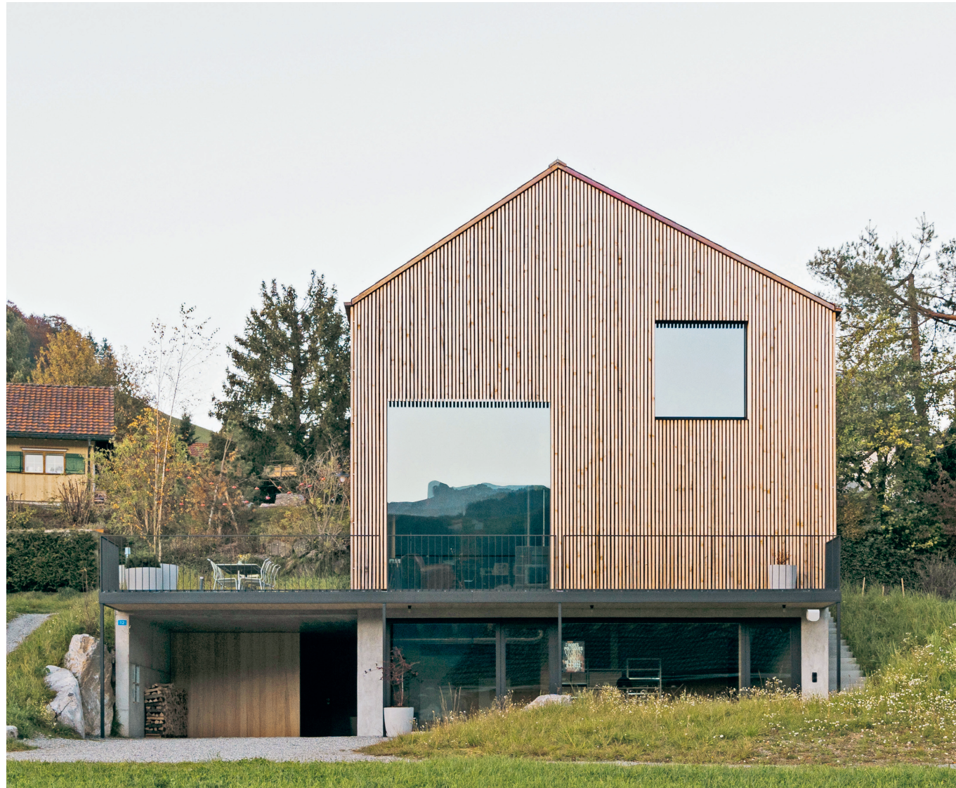
Das neue Einfamilienhaus lehnt sich in der Form an alleinstehende Ställe an, sie dominieren immer noch das Bild rund um Appenzell. Das Sockelgeschoss bleibt mit dem Atelier einladend offen, im Gegensatz zu den geschlossenen Garagentoren.
