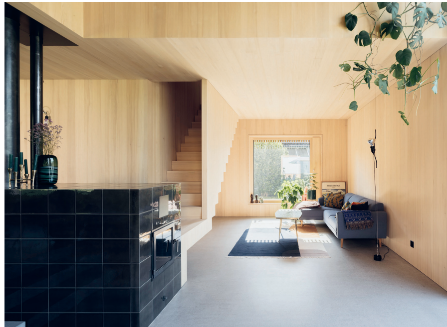
Der Speicherofen ist das zentrale Element im Erdgeschoss. Er kann fast das ganze Haus heizen.
