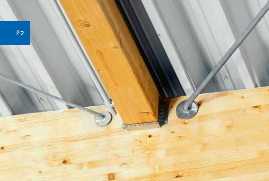
◀ Detailausschnitt der Dachkonstruktion
