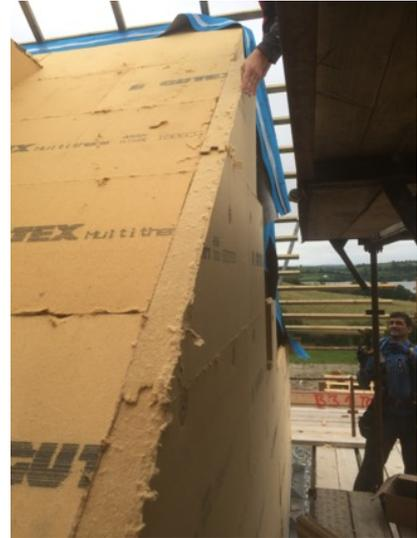
Auf dem Steildach und an der Fassade dämmt die feuchteabweisende Holzfaserdämmplatte GUTEX Multitherm. Der Sparrenzwischenraum wurde anschließend von innen mit GUTEX Thermofibre verfüllt.
