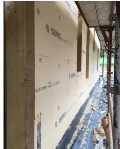
Auch die Gefache an der Außenfassade wurden mit der Holzfaser-Einblasdämmung verfüllt. Für die Schulung zur setzungssicheren Verarbeitung der Einblasdämmung kam Jan Hasemann, GUTEX Key Account Thermofibre, gern selbst nach Irland und schulte die irischen Verarbeiter.
