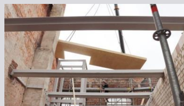
Ende Juni 2021: Zwischendecke mit MAGNUMBOARD® OSB
