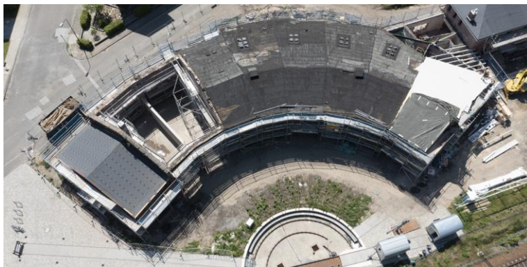
Der ehemalige Lokschuppen: das markante halbrunde Gebäude aus der Vogelperspektive
