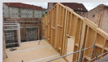
Mitte Juli 2021: Einbau einer OSB-Innenwand im 2. Obergeschoss
