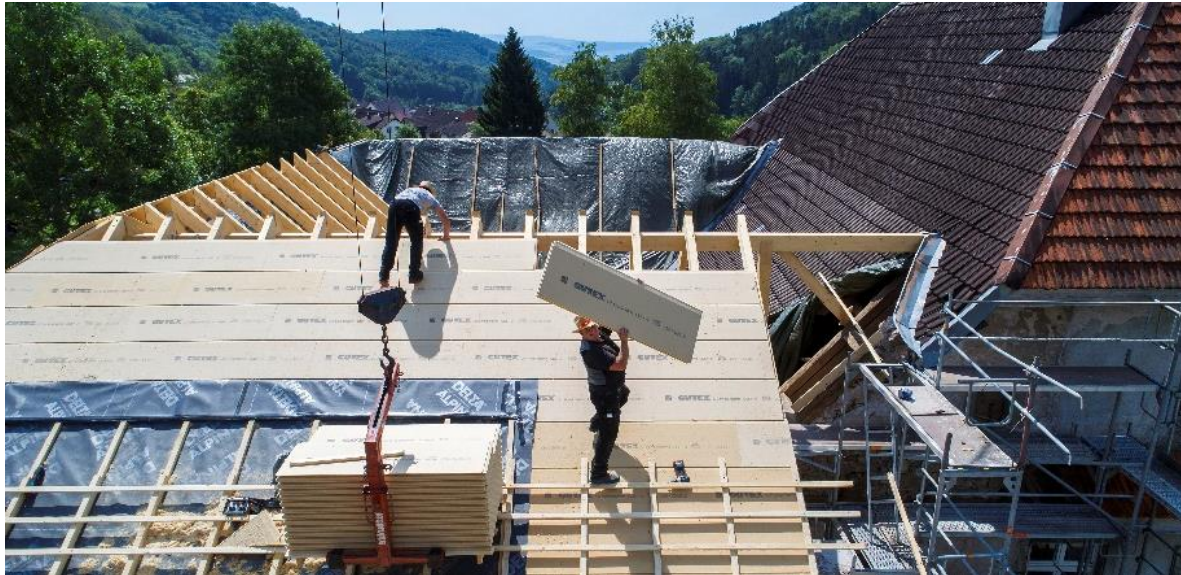
Abb. 4: Zur Erreichung der Klimaschutzziele muss der Gebäudebestand in Deutschland energetisch saniert werden. Holzfaserdämmung von GUTEX sorgt auf wohngesunde und nachhaltige Art und Weise für den benötigten Wärmeschutz. © GUTEX/Martin Granacher
