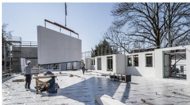
Nicht nur die niedrigeren Preise und ein seit Jahren stabiles Preisniveau sprechen für den Einsatz von fermacell® Gipsfaser-Platten im Holzbau: Sie können wie Holzwerkstoffplatten statische Funktionen übernehmen und bieten eine Fülle von Vorteilen. Bildnachweis: James Hardie Europe GmbH
