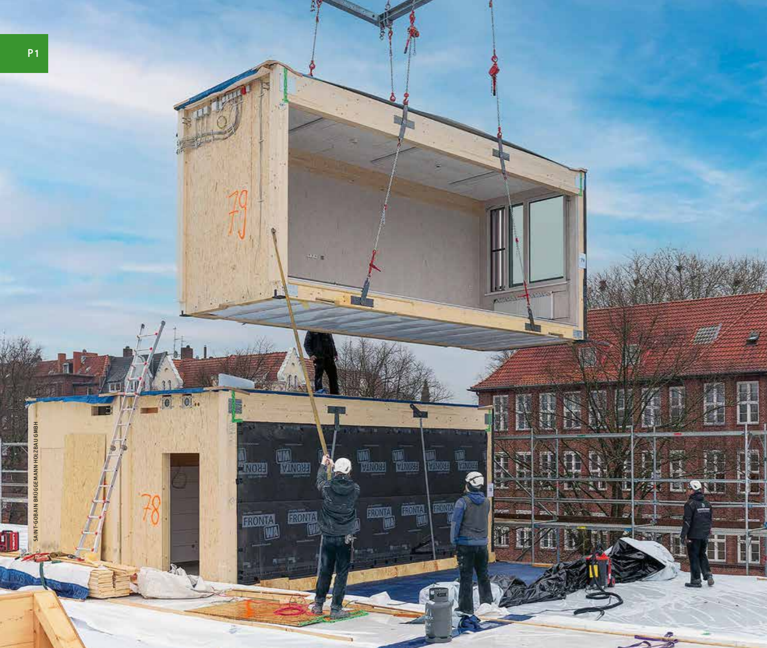
▲ Montage der Module mit einem Mobilkran
