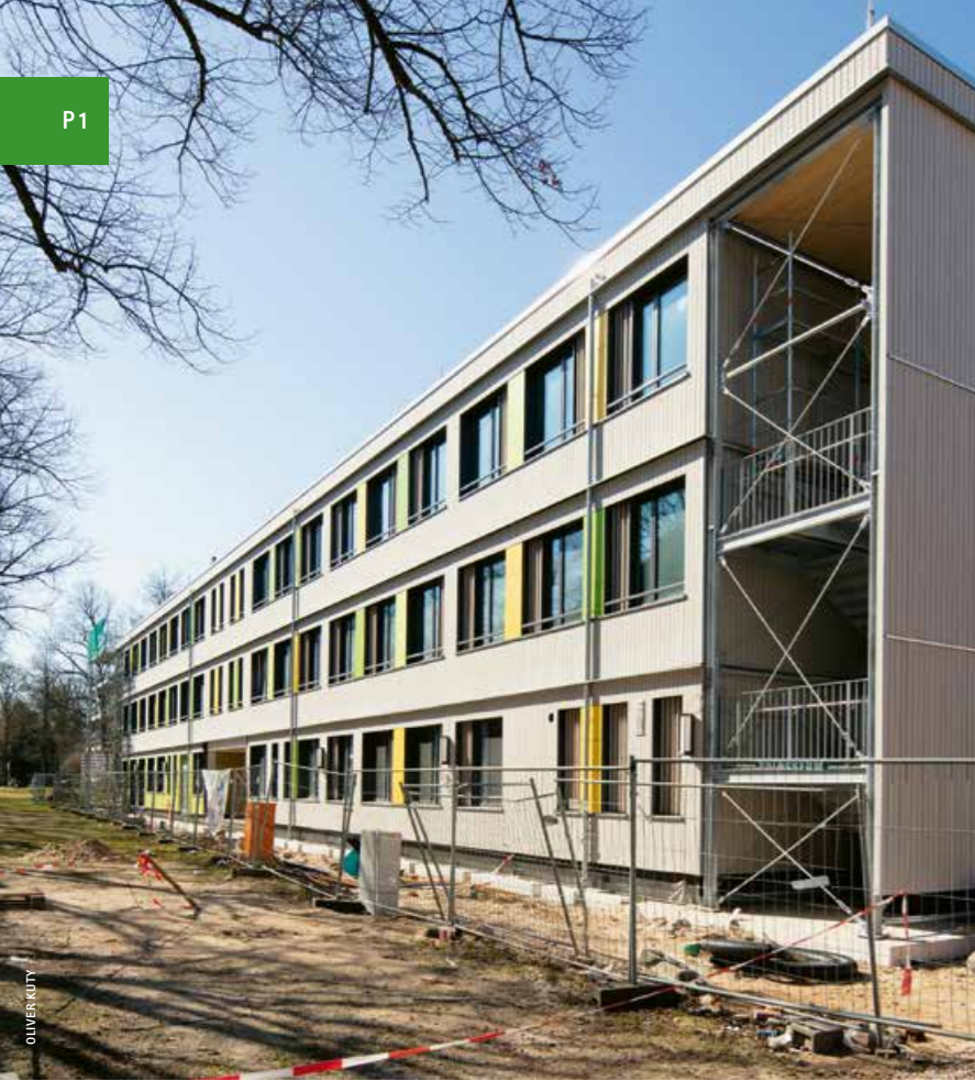
◀ Ein inneres Treppenhaus und zwei frei stehende äußere Treppenhäuser übernehmen bei dem dreigeschossigen Riegel die Erschließung
