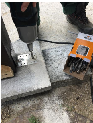
HECO_Referenz_Boulderwand_München_9 Über Winkelstücke wurden die Balken der Unterkonstruktion mit dem selbstschneidenden Schraubanker MULTI-MONTI-plus sicher im Boden befestigt. (Bild: HECO-Schrauben)
