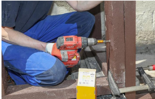
HECO_Referenz_Boulderwand_München_5 Für die Unterkonstruktion wurden Holzbalken der Maße 6 x12 cm mit HECO-Schrauben fixiert. (Bild: Bernd Wackerbauer für HECO-Schrauben)
