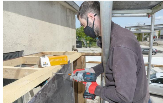
HECO_Referenz_Boulderwand_München_6 Die Holzbalken-Unterkonstruktion der Boulderwand wurde mit HECO-Schrauben zeitsparend und präzise montiert. (Bild: Bernd Wackerbauer für HECO-Schrauben)
