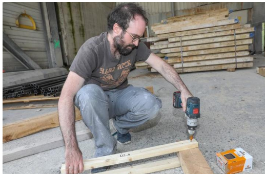
HECO_Referenz_Boulderwand_München_5 Für die Unterkonstruktion wurden Holzbalken der Maße 6 x12 cm mit HECO-Schrauben fixiert. (Bild: Bernd Wackerbauer für HECO-Schrauben)
