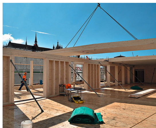
Blick auf die Baustelle über den Dächern im Zentrum von Lausanne.
