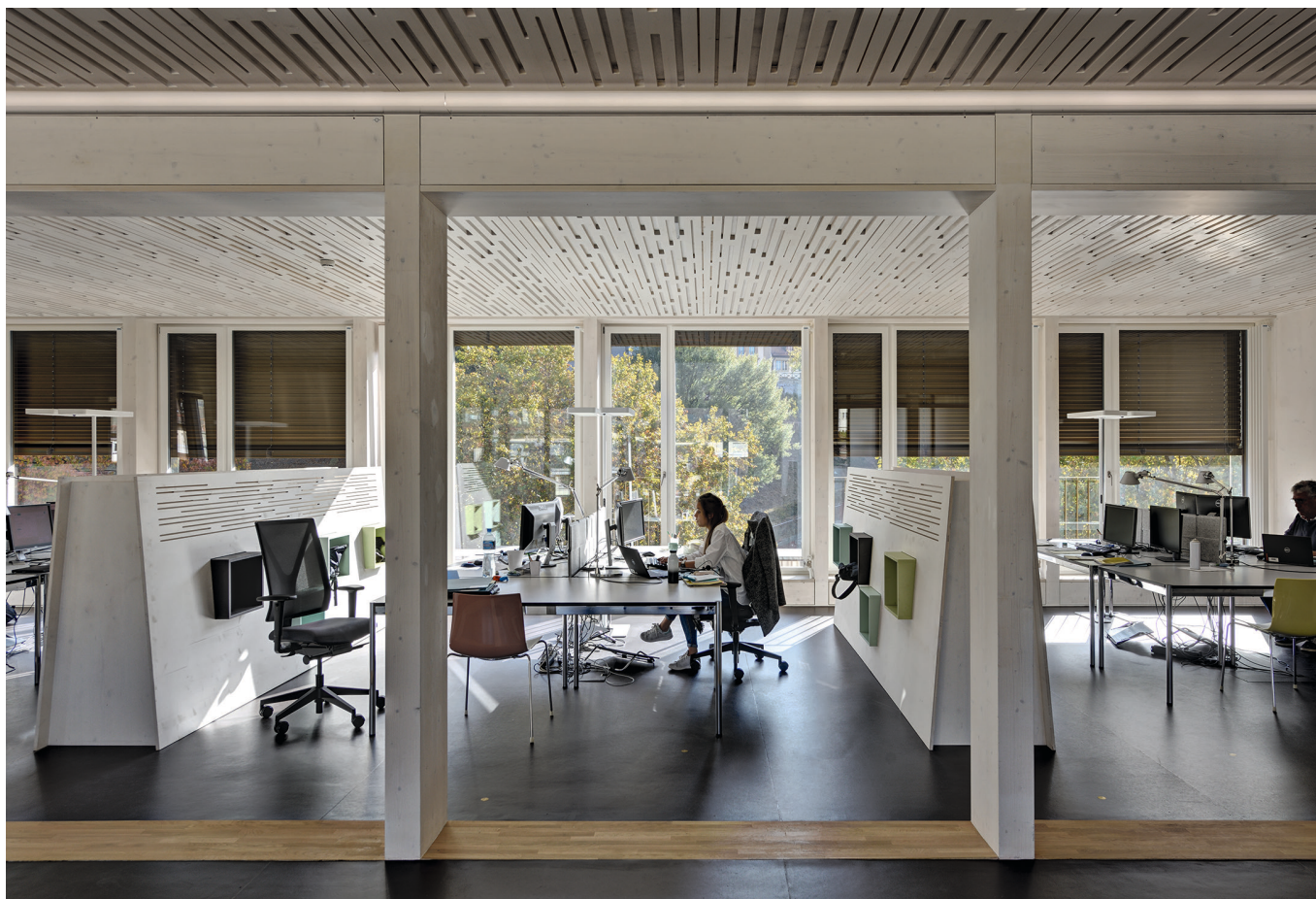
Auf dem Dach entstand eine neue Etage mit Grossraumbüros aus vorgefertigten Holzelementen in modularer Architektur.
