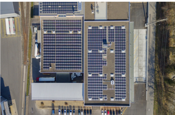
Der Eigenenergiebedarf wird dank Photovoltaik-Anlagen auf dem Dach sowie transluzider PV-Fassade mehr als abgedeckt.
