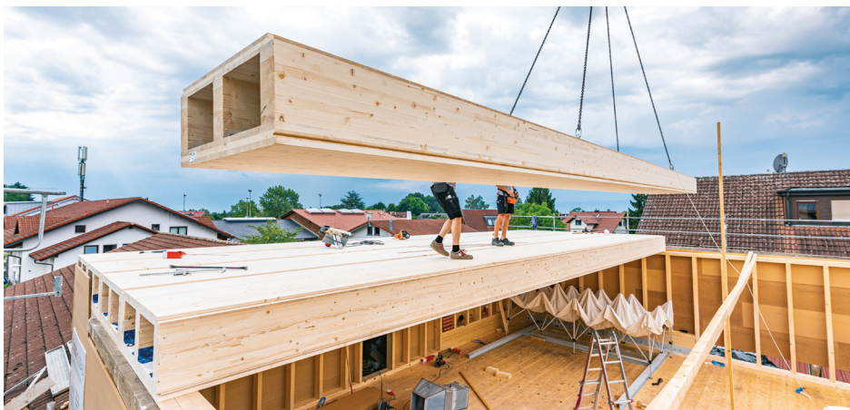
Aufstockung mit CLT BOX Deckenelementen als Einfeldträger mit 11m Feldlänge durch Joos Holzbau GmbH
