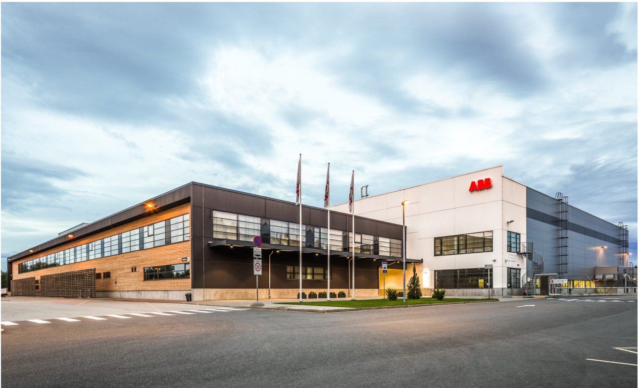
Bürogebäude von ABB im estnischen Tallinn mit Brandschutz der Holzfassade von Nordtreat
