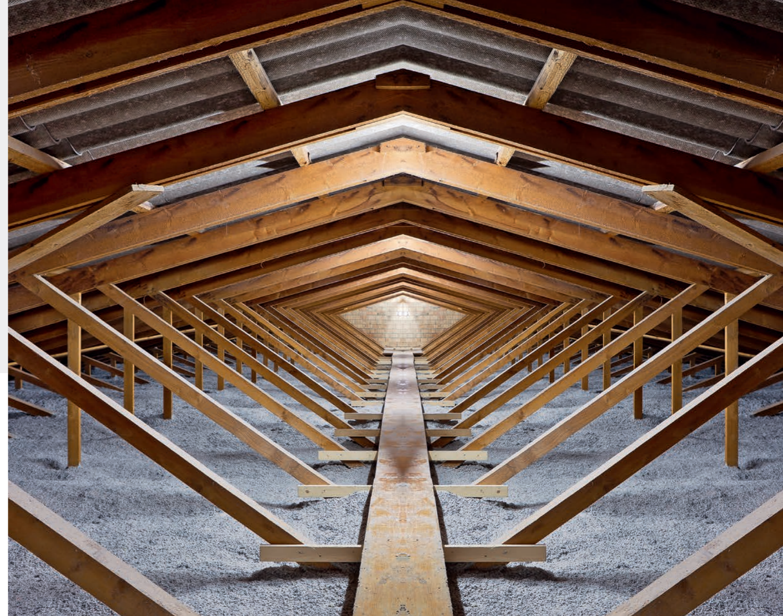
Offen aufgeblasen mit Laufsteg in der Mitte (eine offen aufgeblasene Dämmschicht ist nicht druckfest).
