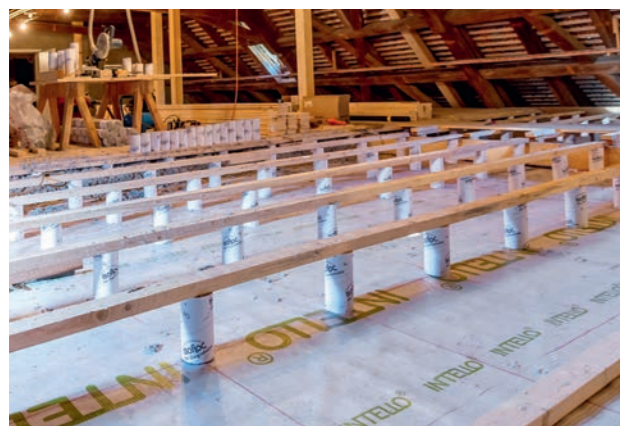
Aufgestellte Dämmhülsen, bevor der Gehbelag darüber verlegt wird.
