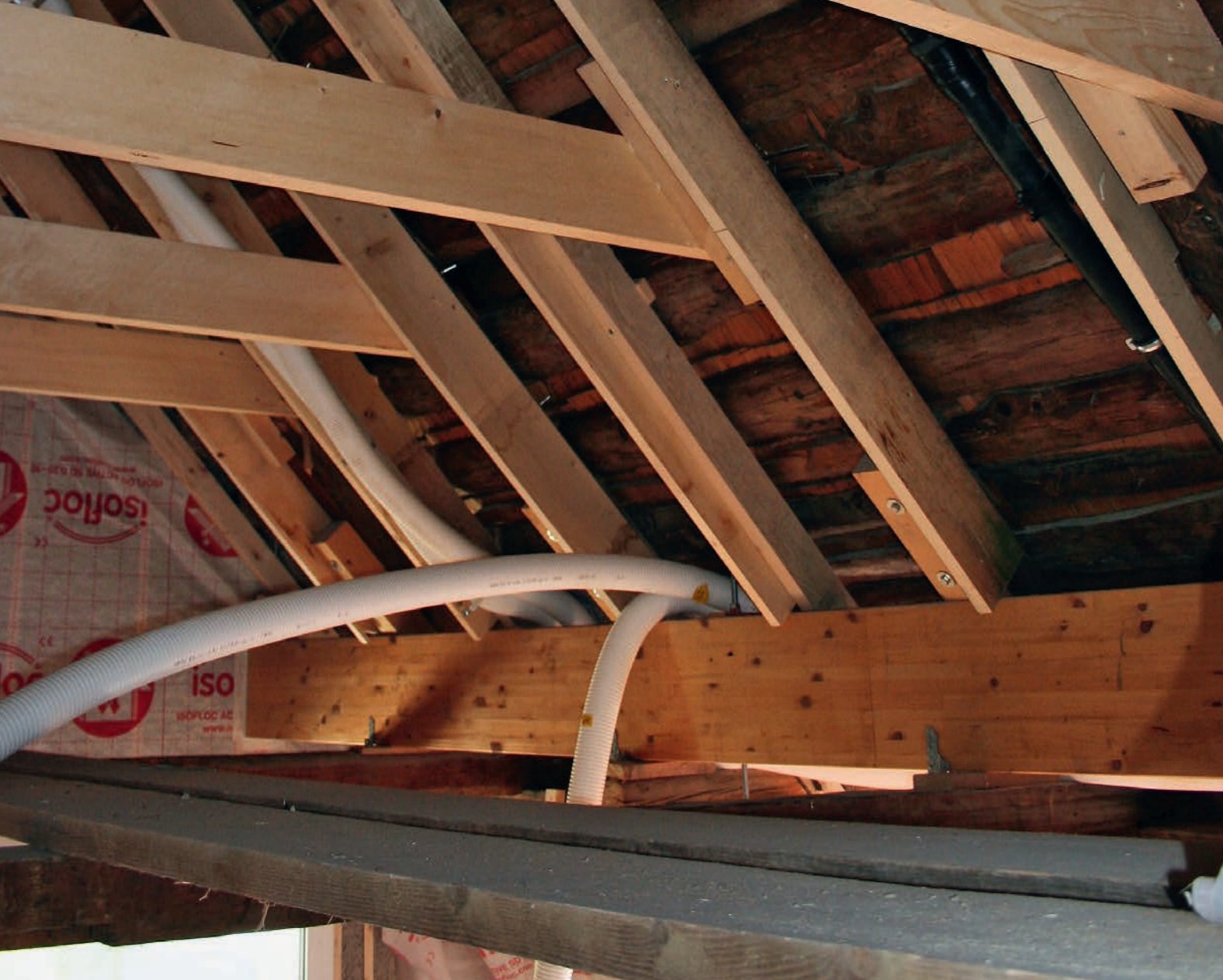
Unterschiedliche Sparrendimensionen und -sprünge – verwindetes Holz erhält seitliche Schiftung zur Erhöhung des Dämmquerschnitts und zur Nivellierung. isofloc garantiert eine fugenlose und kompakte Dämmschicht.
