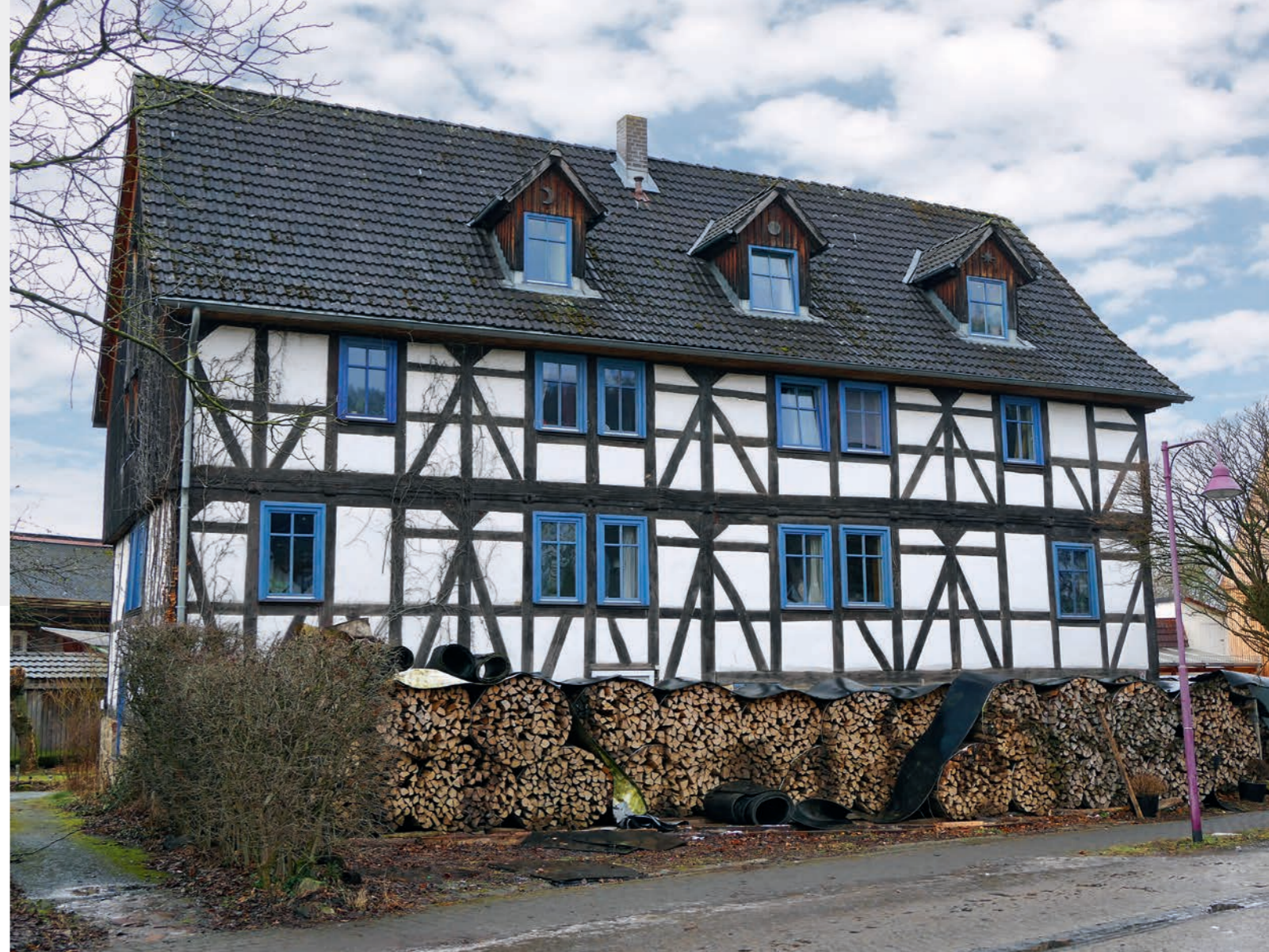
Bei erhaltenswerten Sichtfachwerk-Gebäuden ist eine Innendämmung oftmals die beste Lösung.
