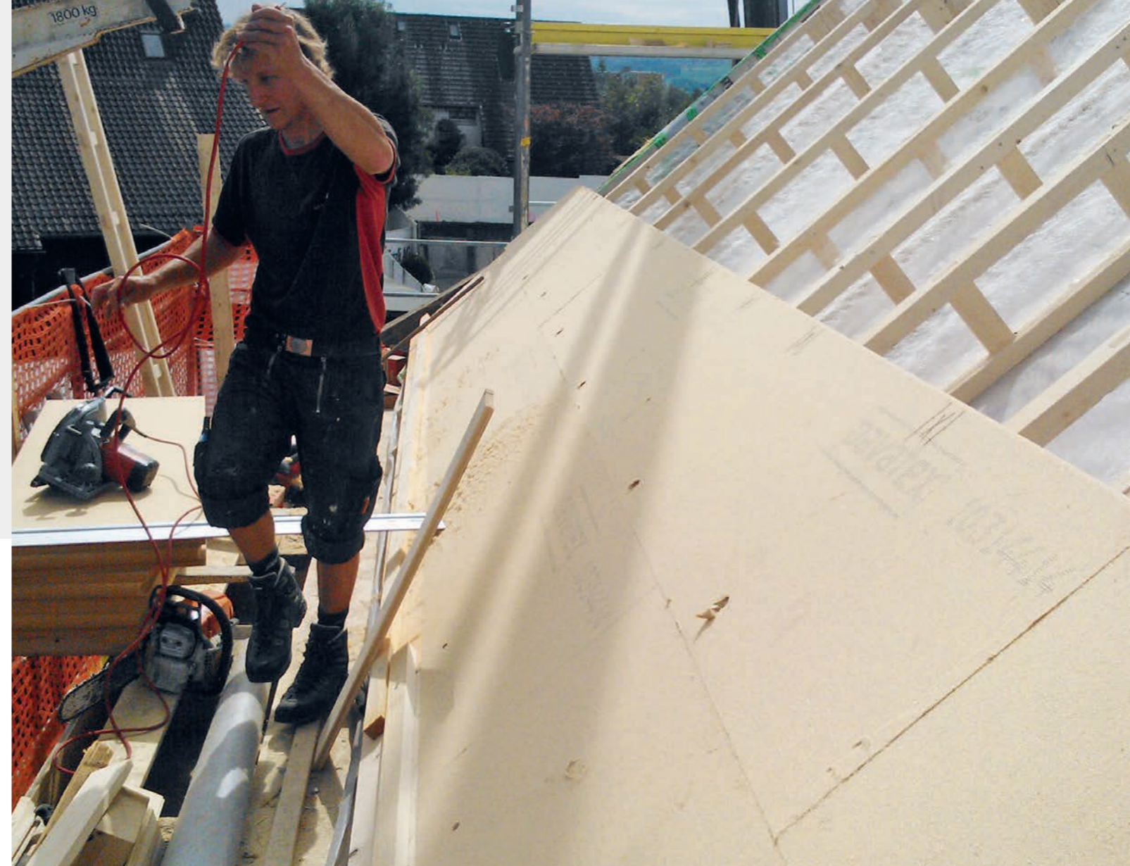
Das Unterdach wird mit Pavatex-Weichfaserplatten erstellt. Der Dämmhohlraum zwischen den U*psi-Trägern wird mit isofloc Zellulosefasern ausgedämmt.
