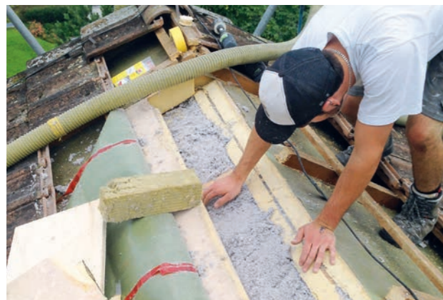
Einblasen der vorhandenen Hohlräume vom First aus über die vorhandene Dämmschutzschicht. In diesem Fall anstelle der Holzschalung eine PU-Dämmplatte.
