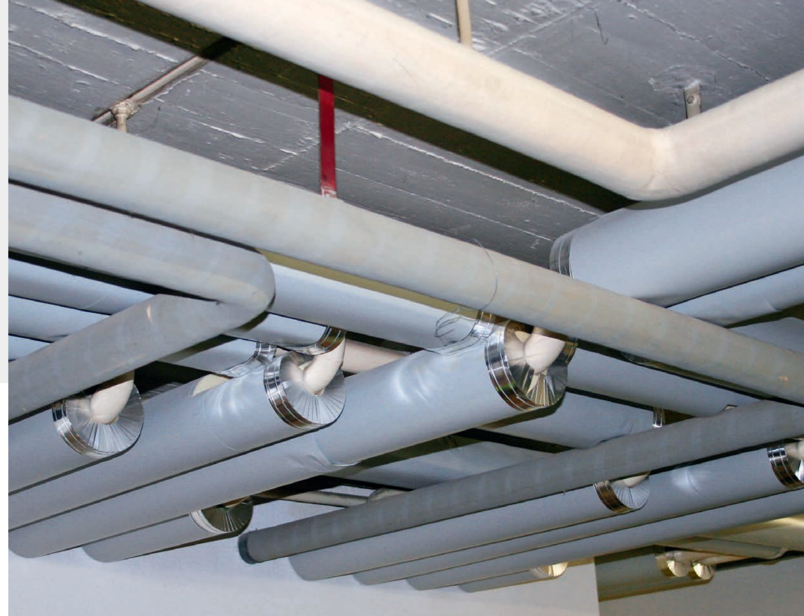
Die unterschiedlichen Höhen und Abstände zwischen den Installationen und zur Kellerdecke können hohlraumfrei mit isofloc Zellulosefasern ausgeblasen werden.
