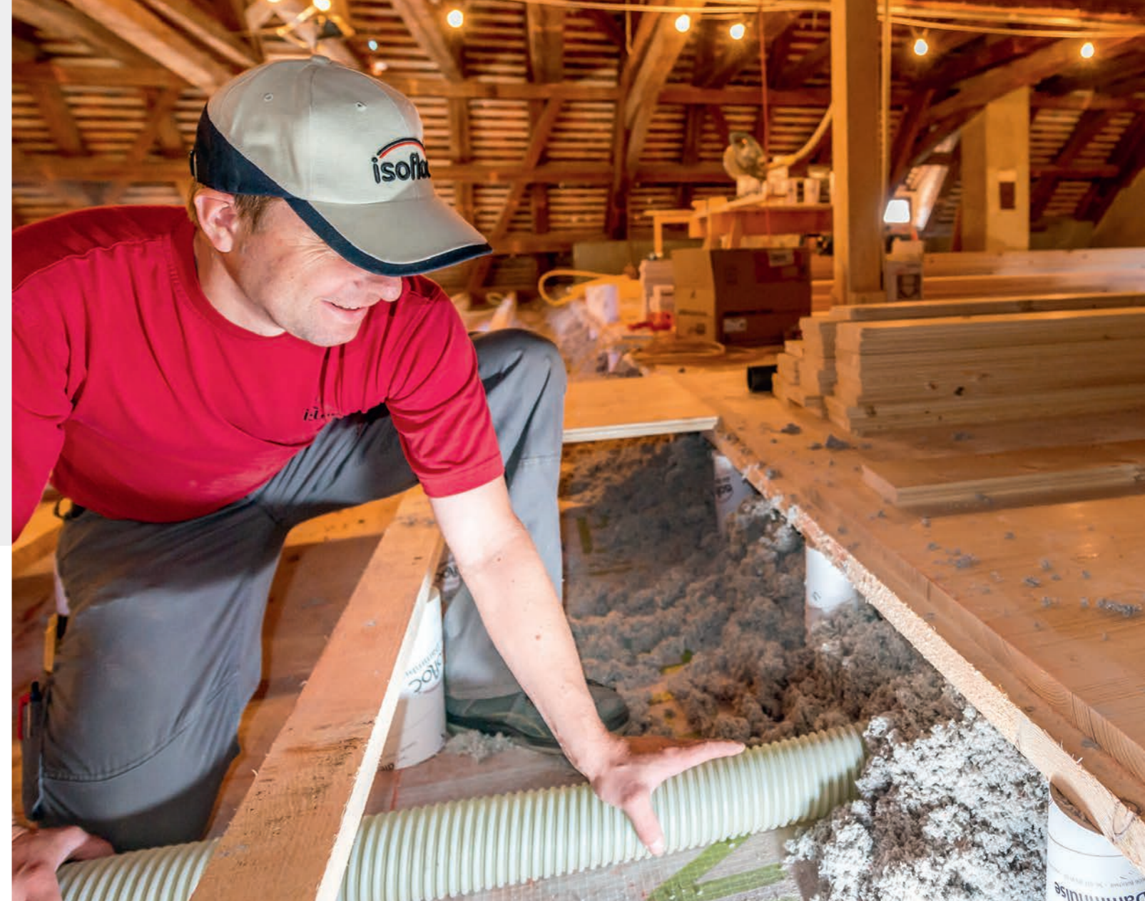
Dämmhülsen sind aufgestellt und mit Gehbelag gedeckt. Jetzt wird isofloc fugenfrei und passgenau eingeblasen.
