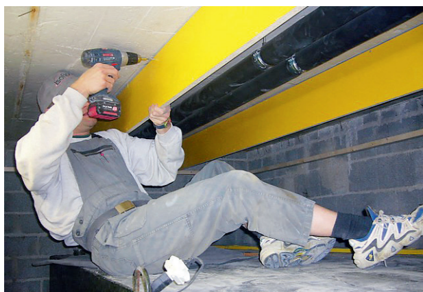
Betonkellerdecke mit Montage der Distanzstege für den mit isofloc Zellulosefasern auszublasenden Dämmhohlraum.
