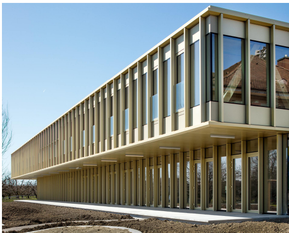
Auskragendes neues Obergeschoss auf saniertem Erdgeschoss des Schulhauses in Sutz-Lattrigen (© Indermühle Bauingenieure)
