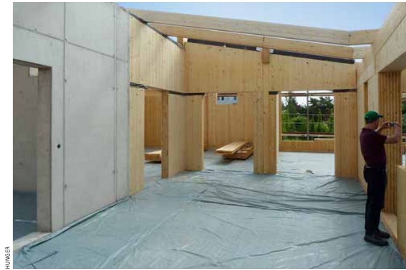
Der in der Luft hängende Sparrenstoß
