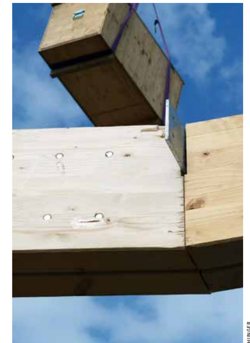
Im Detail: die biegesteife Verbindung der gegenläufigen Sparren
