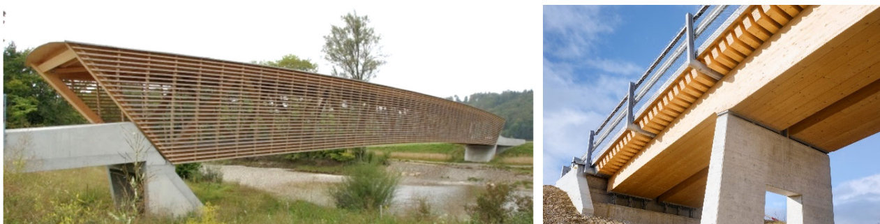
Abb. 16: Neumattbrücke mit Beplankung als konstruktiv geschützte Fachwerkbrücke (links), Überführung in Horen mit Witterungsschutz der Tragglieder durch ausreichenden Überstand (rechts)
