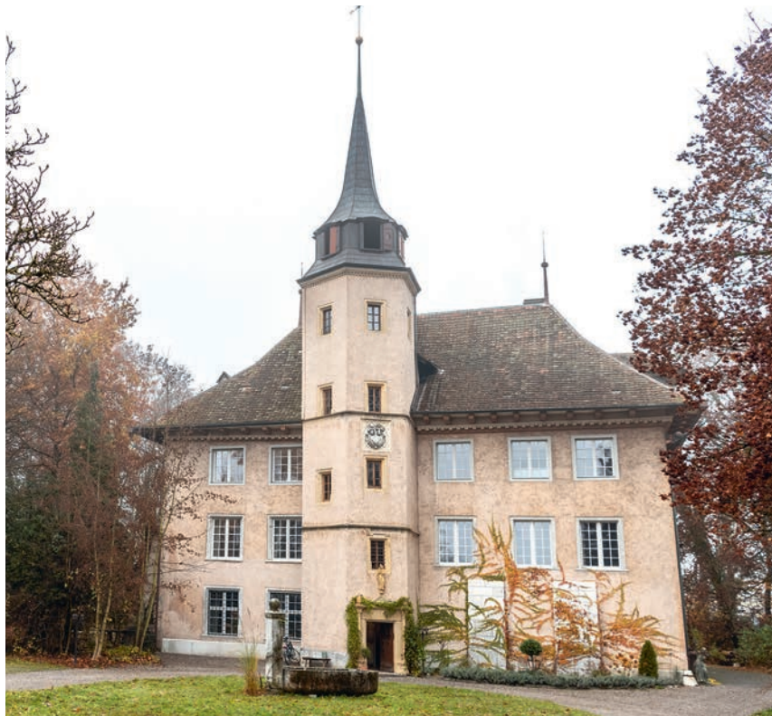
Das Haupthaus wurde 1609 erbaut. 1619 erfolgte die Erweiterung mit dem Treppenturm.
