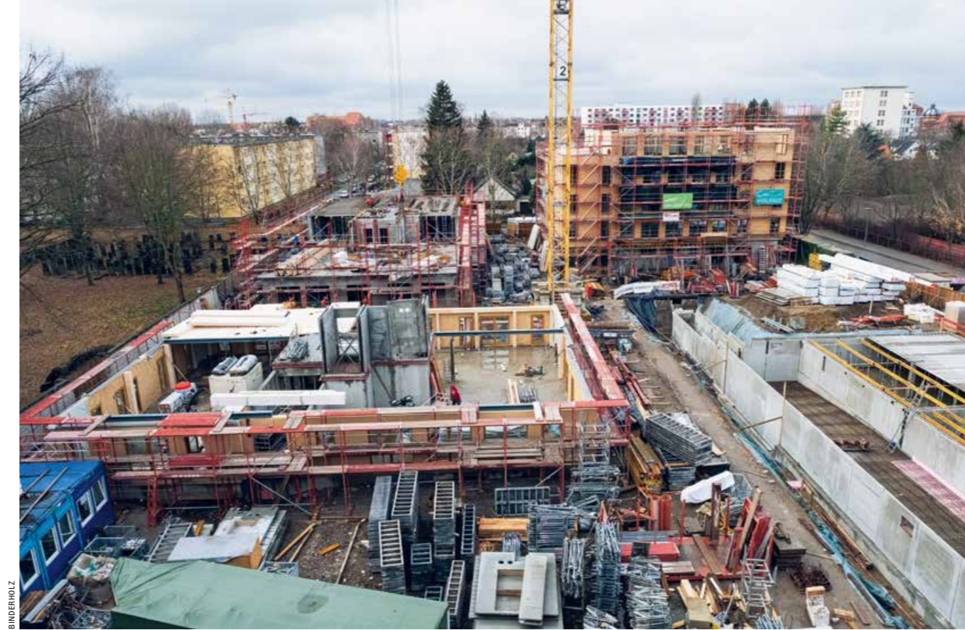
◀ Der Blick über die Baustelle zeigt: Lagerplatz ist rar
