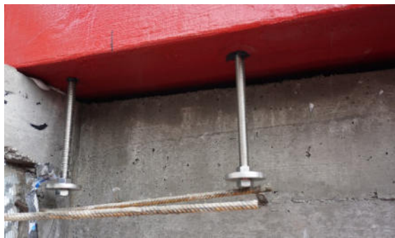
Die integrierten Gewindestangen zur Abhubsicherung Das Betonfundament wird nachträglich gegossen
