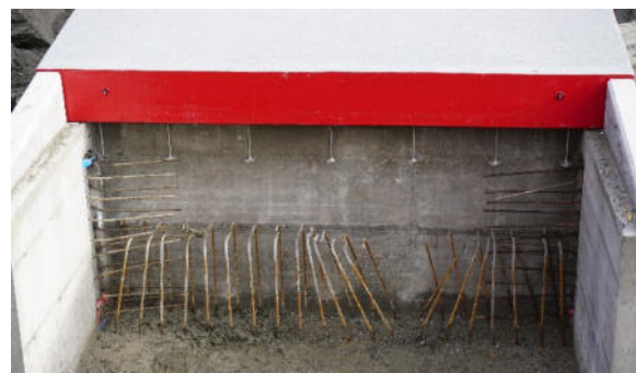
Die integrierten Gewindestangen zur Abhubsicherung Das Betonfundament wird nachträglich gegossen
