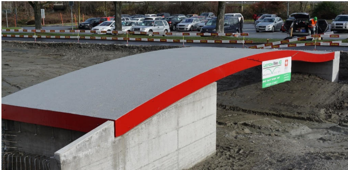
Die installierte Brücke; Das Geländer wird durch eine ortsansässige Firma montiert
