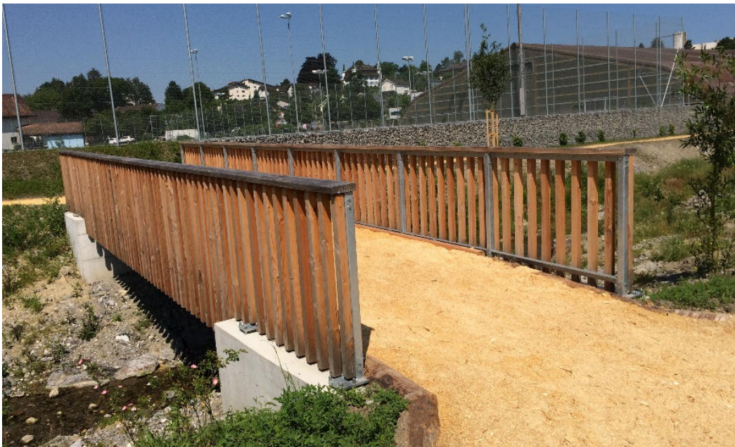
Dauerhafte Holzbrücke aus dem System SYNBOS mit Hackschnitzelbelag und Holzgeländer
