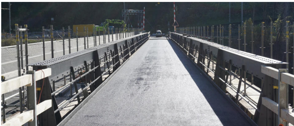
Die fertige Brücke mit aufgebrachtem Walzasphalt
