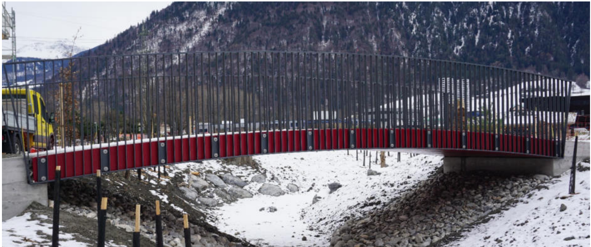
Die kleine Brücke mit bereits montiertem Geländer
