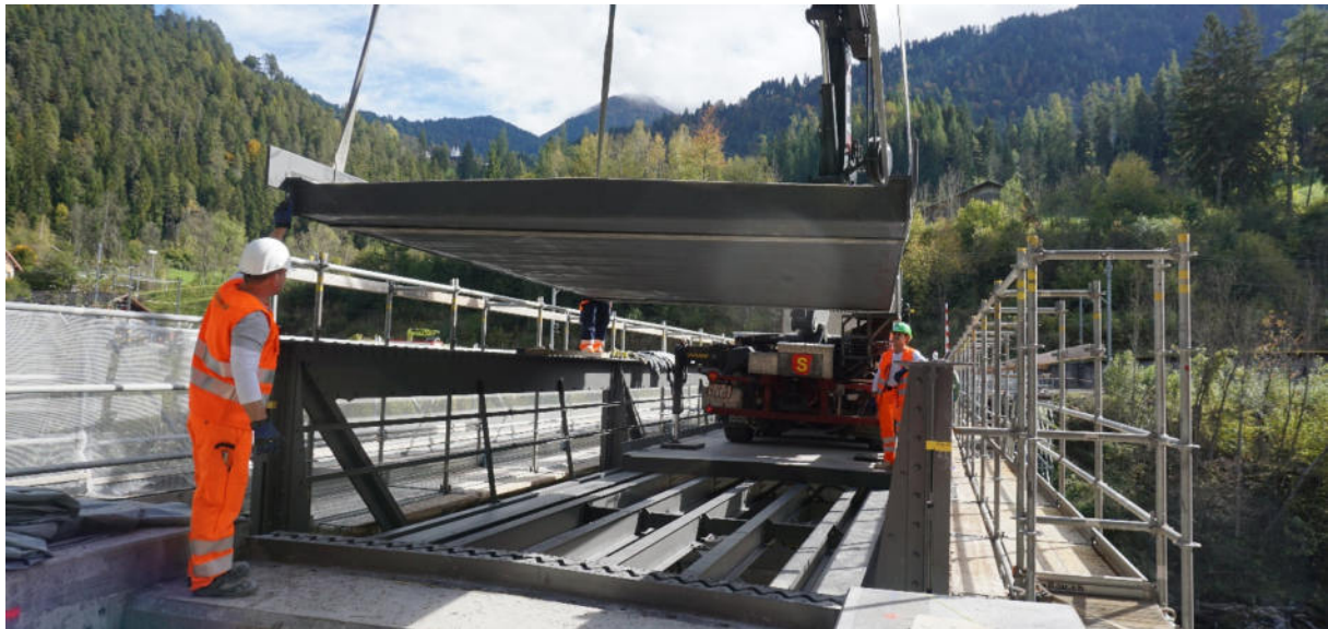
Montage des zehnten und letzten Elementes nach gerade einmal 4 Stunden
