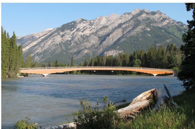
Fußgängerbrücke über den Bow River in Banff, Kanada (© StructureCraft Builders Inc.)
