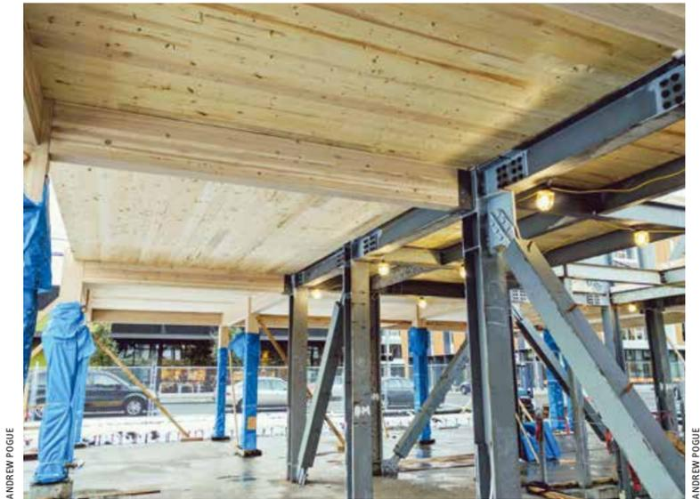
▲ Die Verbindung aus BSH und Stahl holt das Beste aus beiden Materialien heraus
