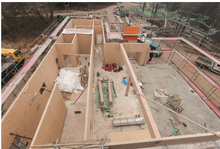
Blick von oben auf das entstehende Verwaltungsgebäude mit Gastronomie und Küche
