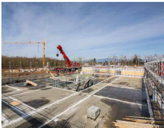
▲ Großbaustelle Schulneubau in Holz-Modulbauweise
