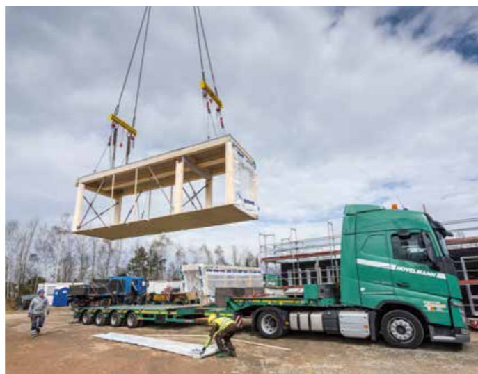
▲ Per Lkw werden die vorgefertigten Module angeliefert
