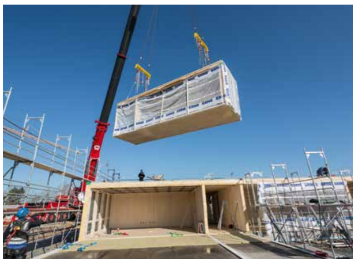
▲ Aus einzelnen Holzbaumodulen entstehen Klassenräume
