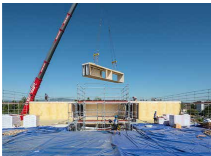
▲ Modul um Modul wird das Gymnasium errichtet
