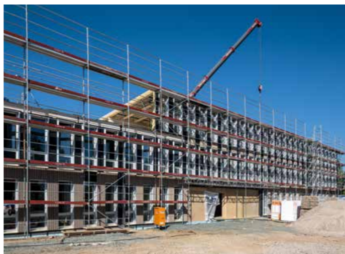
▲ Das Schulgebäude des Campus entsteht
