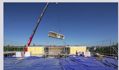
Modul um Modul entsteht das neue Schulgebäude
