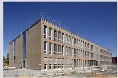
Das neue Schulgebäude mit Weißtannen-Fassade und Fensterlaibungen aus eloxiertem silbernem Aluminiumblech
