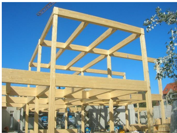
Bild 4: Wirtschaftliche Verbindung, durch hohen Vorfertigungsgrad
