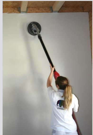
Schleifen der Spachtelflächen vor dem Auftragen von Caparol StuccoDecor Di Luce und Caparol Multistruktur Putz
