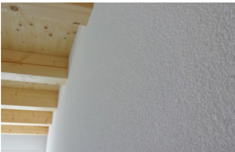
Fertige Oberflächen mit Sto Innenputz
