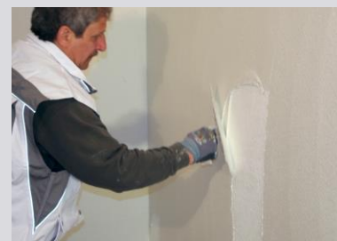
Auftragen der ersten Lage des Putzes
