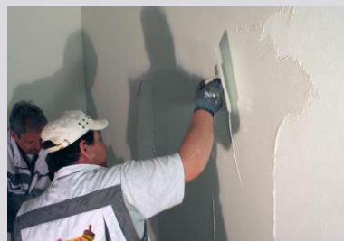
Auftragen der zweiten Lage des Putzes
