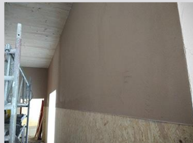
Fertig aufgetragener Knauf Rotkalk Grundputz, auf dem noch die letzte, oberste Schicht (Filz) aufgetragen wird.
