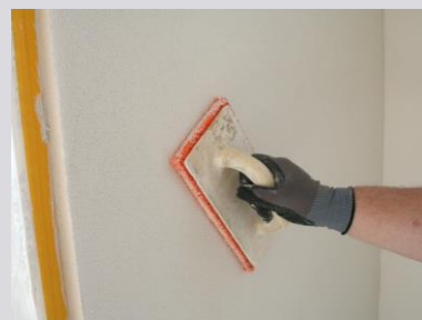
Filzen der Oberfläche
